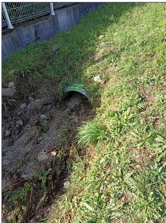
Figure 22. Anomalie n°6 Ø800 obstrué en sortie - Route de la Plaine
