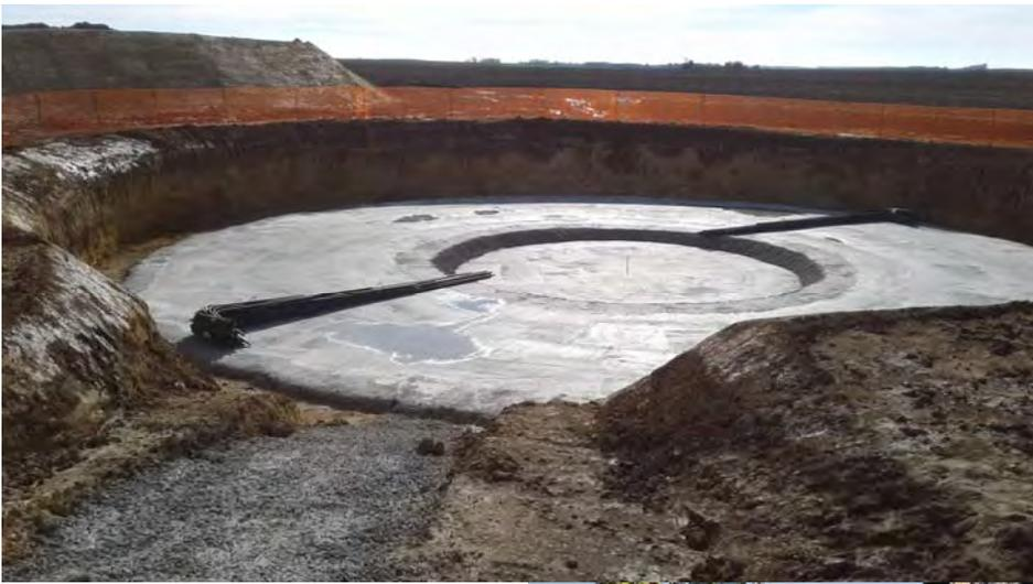
La fondation en béton est coulée. On aperçoit ci-dessous la tranchée par laquelle les câbles électriques sortiront.
