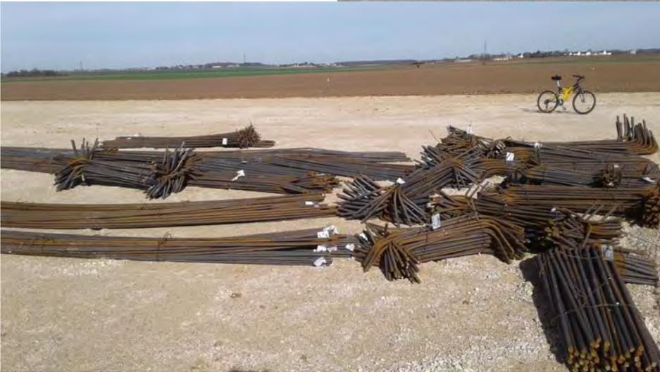
Les "ferrailles" qui renforceront le béton et ci-contre les collerettes sur lesquelles l'éolienne sera boulonnée.
