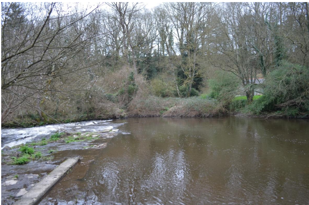
Photo 2022 déversoir. On aperçoit le logement derrière les arbres à droite
