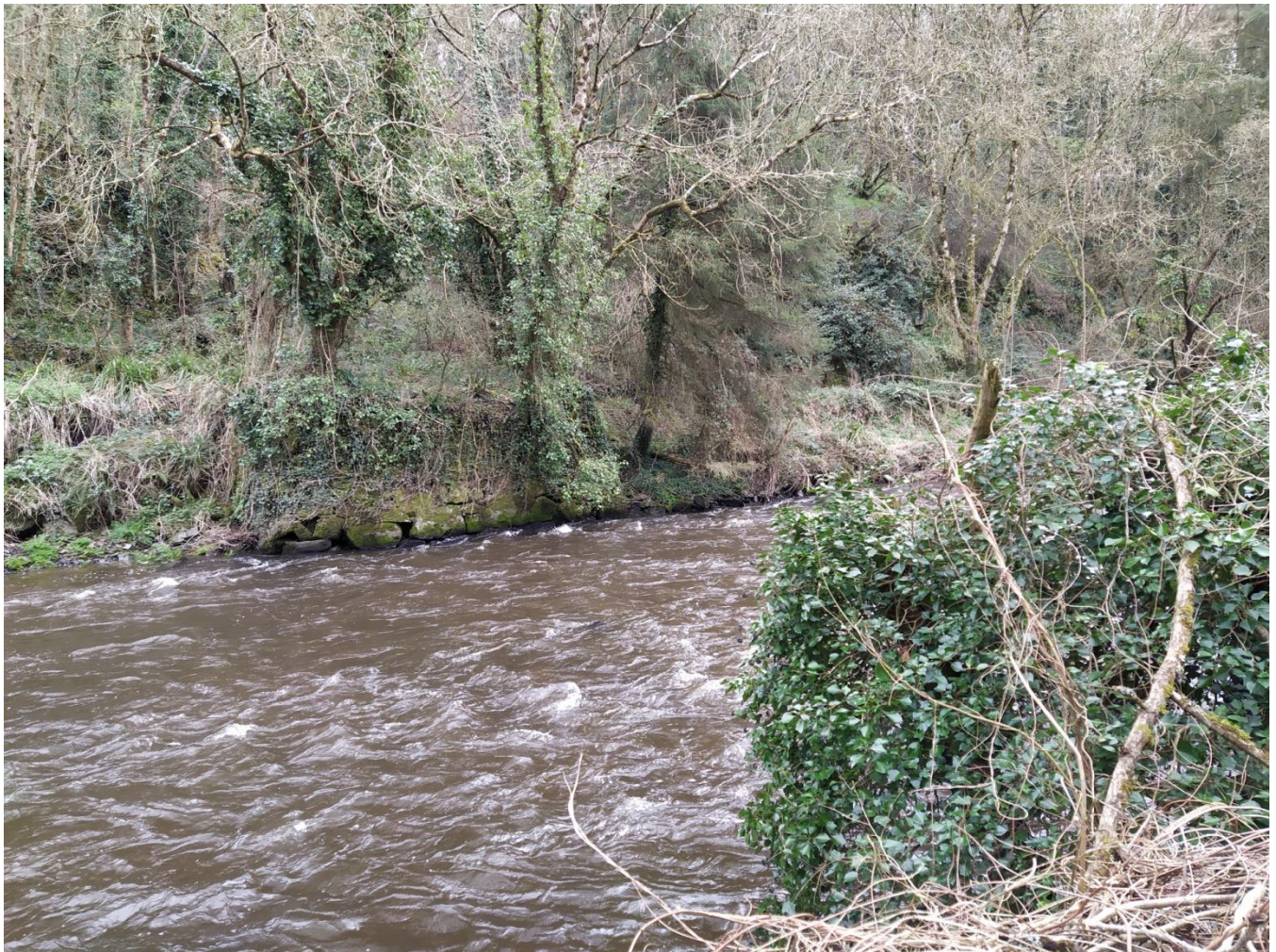
Photo 2022 pilier d'arrivée du pont du moulin sur la rive droite
