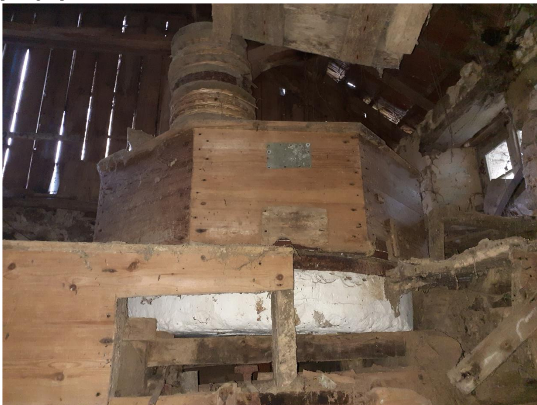
Photo 2022 La meule dormante et l'archure hexagonale
