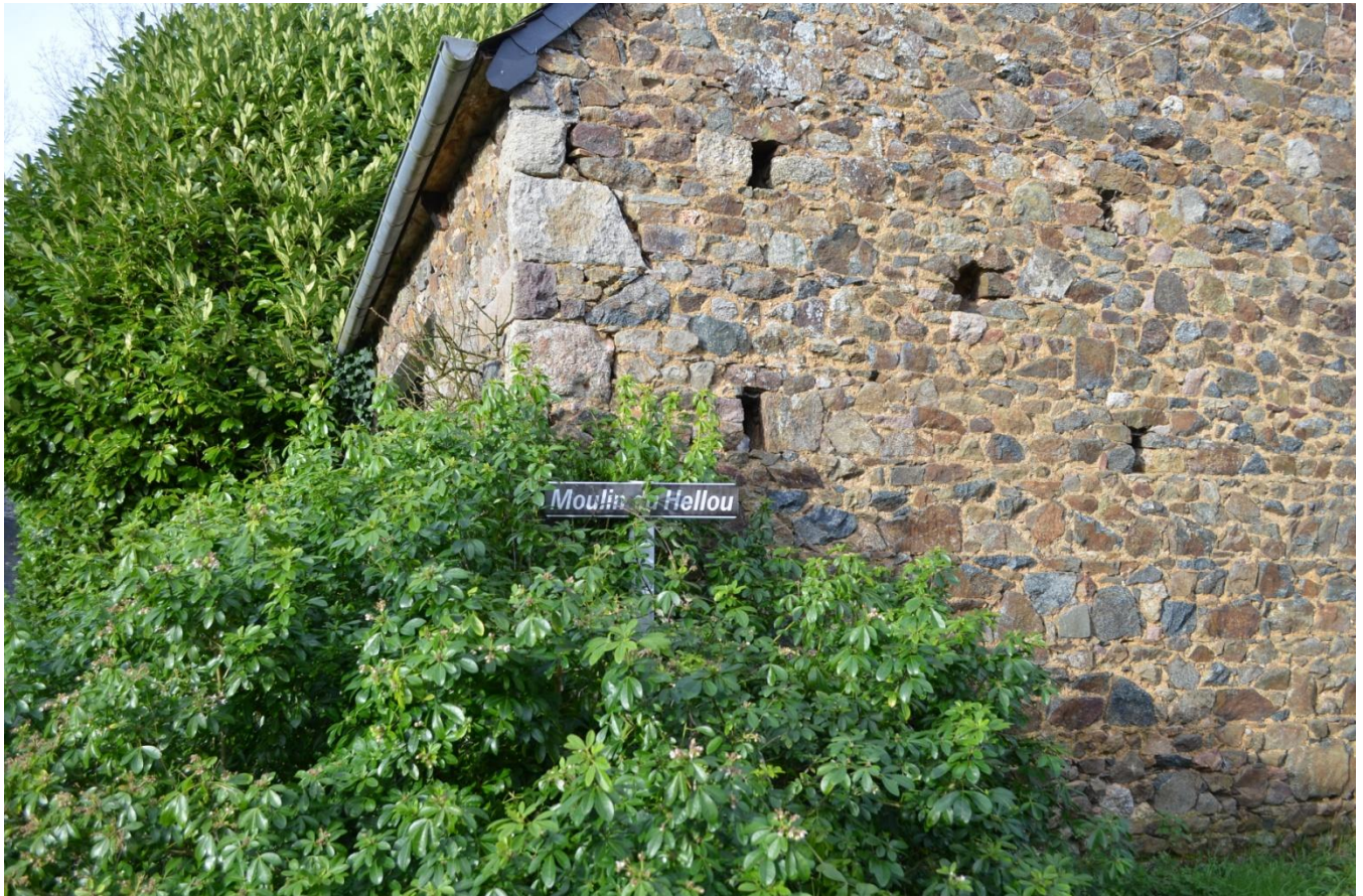
Photo 2019 seul bâtiment restant de l'ensemble des constructions du moulin
