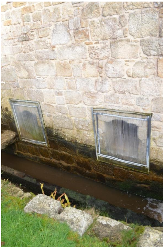
Photo 2019 : emplacement des roues avec la réserve dans le mur pour le passage des axes de roues. En face du premier passage, on voit bien la pierre avec le percement pour le berceau de l'axe.
