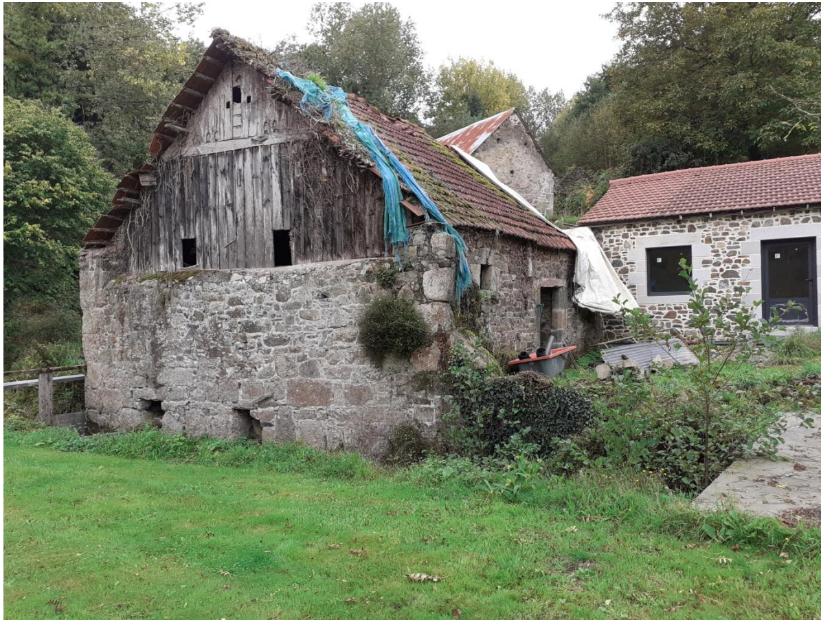
Photo 2022 En haut logement, en dessous boulangerie rénovée et accolé le moulin à restaurer avec les passages pour les axes des roues
