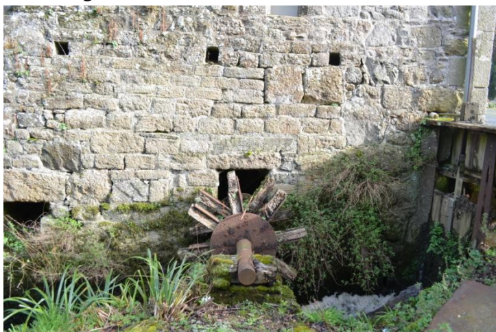
Vu des deux percements pour les axes des roues ainsi que les restes de la roue principale.
