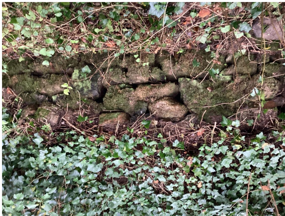
Empierrement du canal de fuite (retour de l'eau du moulin au ruisseau du Paou)
