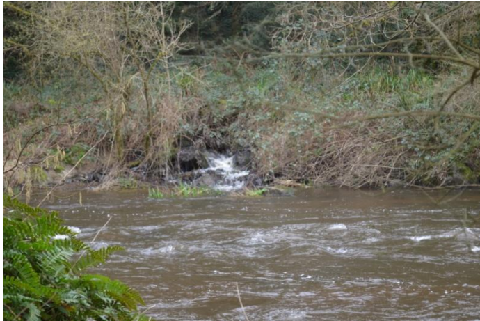
Photo 2022 débouché du canal de fuite en aval du déversoir
