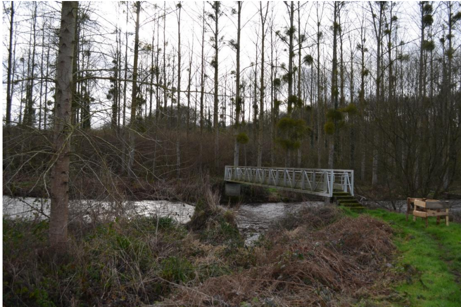
Photo 2019 vue d'accès à la passerelle on devine le reste de bief à gauche du chemin sous les herbes
