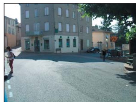
Carrefour RD 50 - Rue du Dronaud - Rue de la Déserte peu sécurisé
