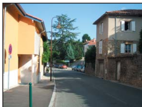
RD 50 sans aménagement particulier dans la traversée d'agglomération
