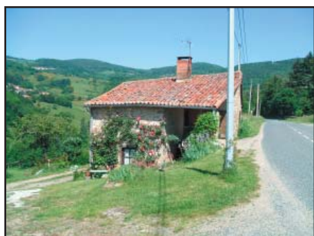
Les bâtiments sous la RD 489
