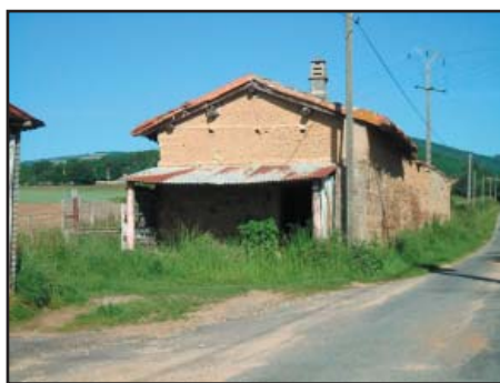
Hangars agricoles sur Croix Blanche
