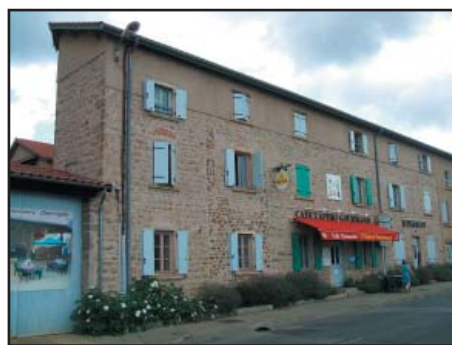
Bâtiment ancien de qualité contre la RD 489
