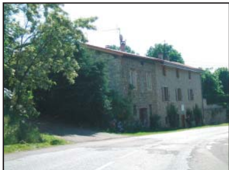
Vue sur les bâtiments Nord de la RD 128
