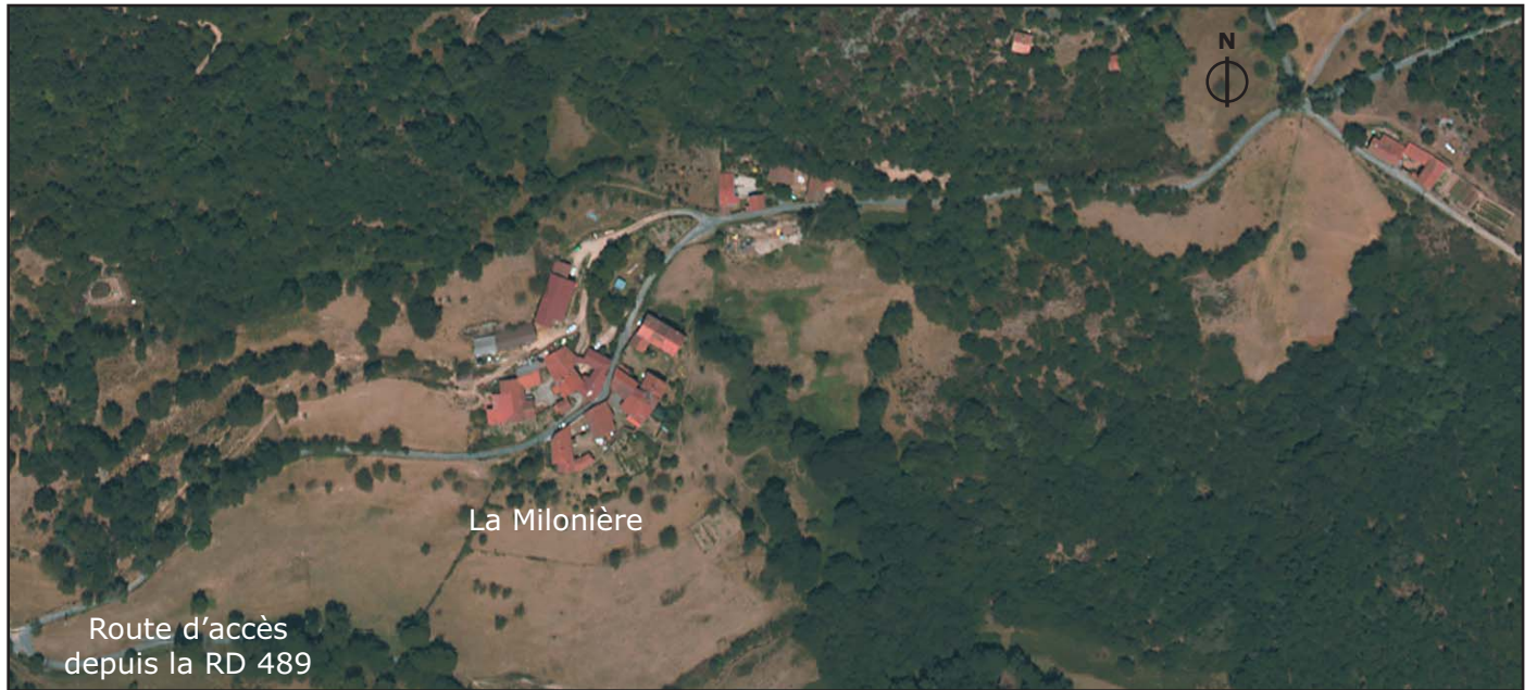
Vue aérienne sur La Milonière
