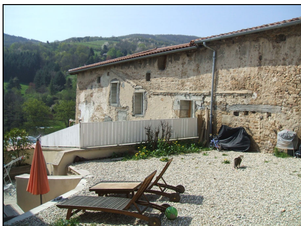
Vue sur le hangar
