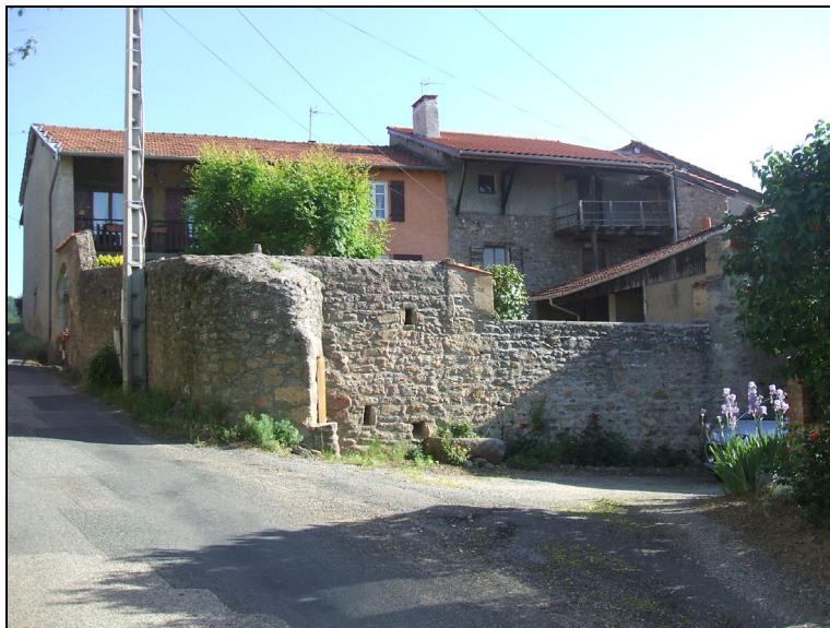
Elément bâti d'intérêt au Crozier
