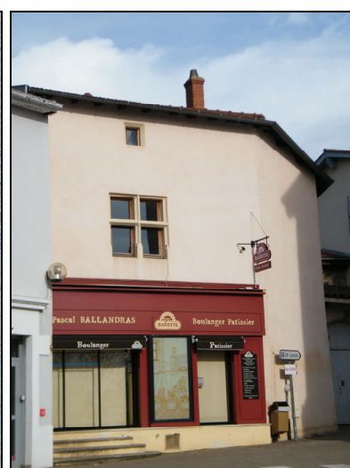
Fenêtre à meneaux dans le bourg
