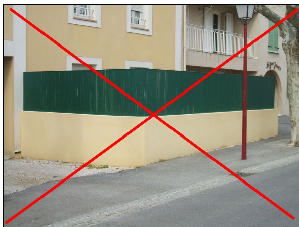
Clôture sur domaine public proscrire (grillage doublé d'une bâche PVC opaque)
