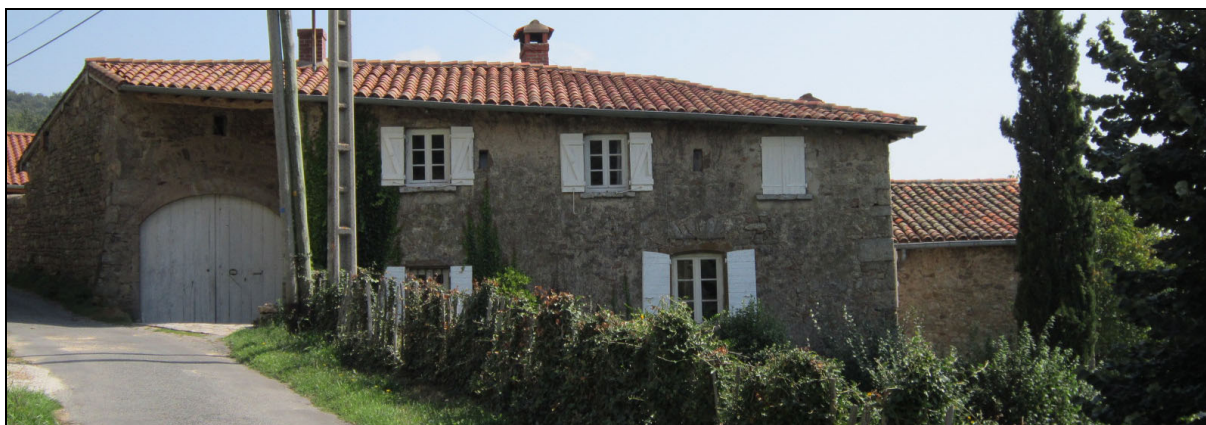
Vue sur la façade ouest du bâtiment
