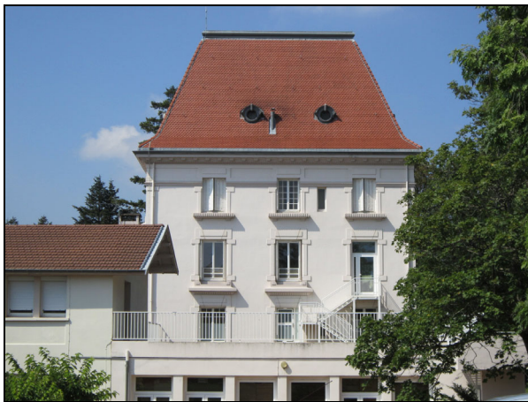
Vue sur les étages de la façade est
