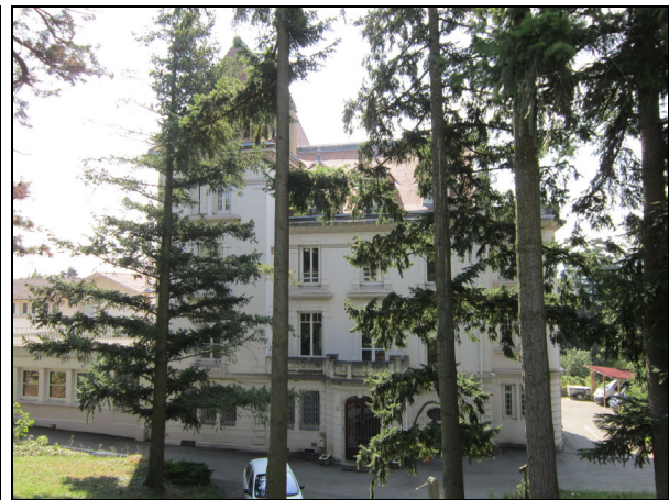
Vue sur la façade nord
