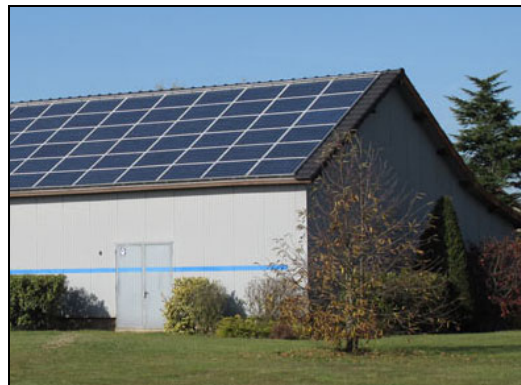
Exemple d'habillage toiture bâtiment d'activité
