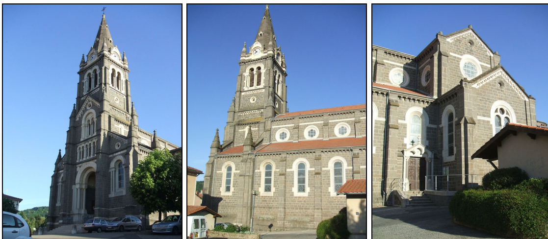
Vues sur l'église de Vaugneray
