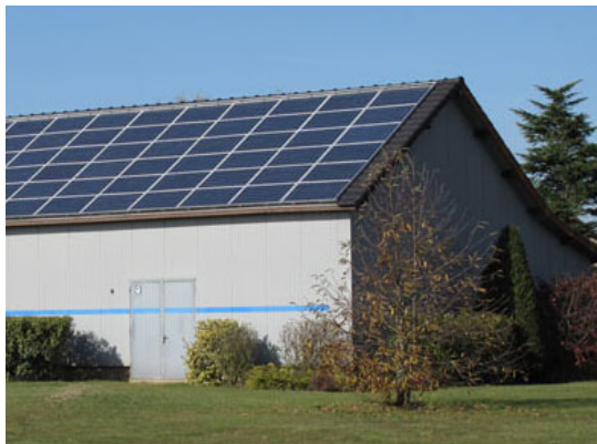
Exemple d'habillage toiture bâtiment d'activité
