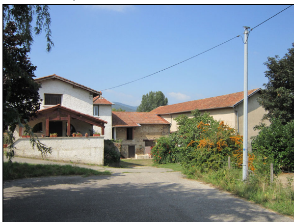
Vue sur la façade principale
