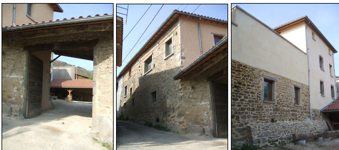
Photographies des bâtiments sis parcelles F 614 et 615
