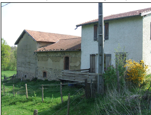
Vue sur la façade arrière
