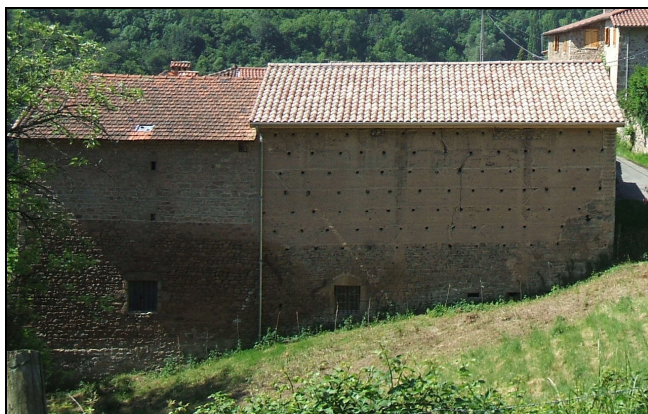
Vue sur le bâtiment
