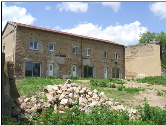
Vue sur la façade est
