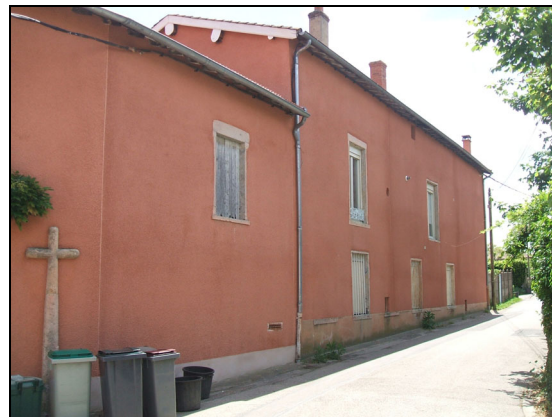
Vue sur la façade est
