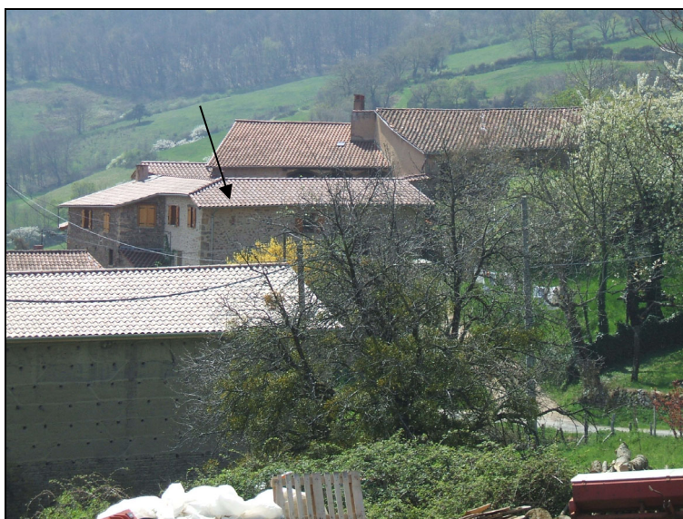
Photographie du bâtiment sis parcelle K 75
