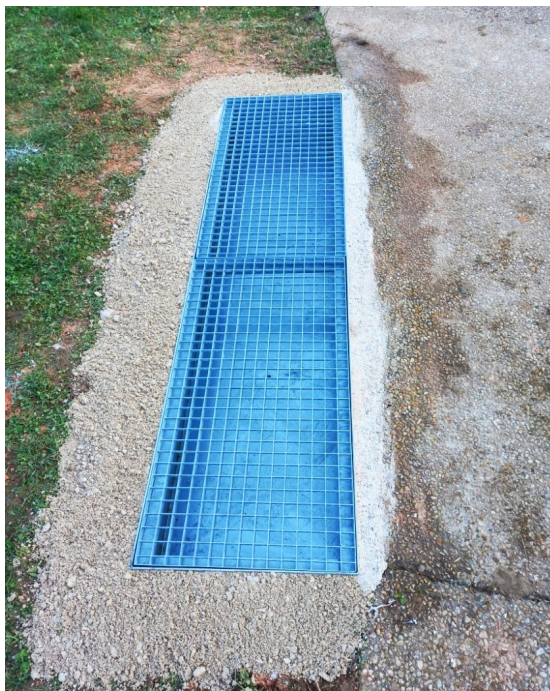
Installation gratte chaussures à la sortie du terrain de football Louis Armand
