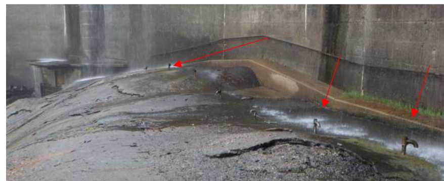
Photographie 14 : Drains actuellement observables au droit du massif de butée du barrage des Cambous
