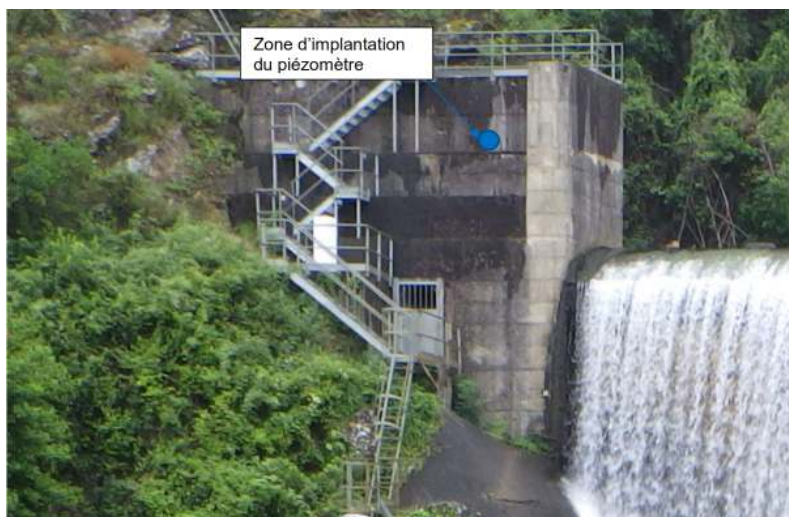
Photographie 13 : Implantation du piézomètre sur la culée rive droite
