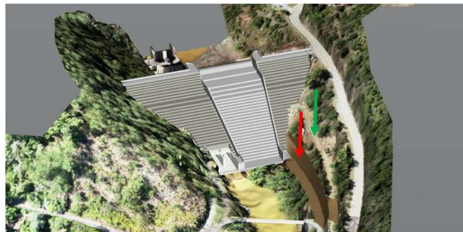
Figure 6 : Création d'un accès au barrage en rive gauche (flèche rouge) et confortement de la piste existante (ancienne RN106) (flèche verte)
