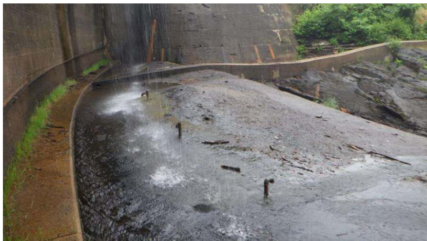
Photographie 9 : Carapace existante en aval rive gauche de l'ouvrage
