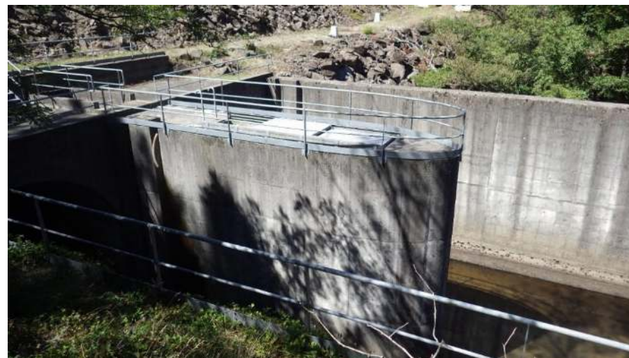
Photographie 5 : Chambre de restitution aval, vue depuis l'aval du barrage
