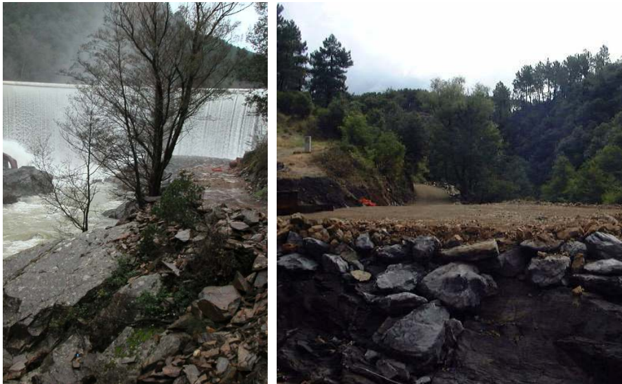
Photographie 11 : Plateforme et piste d'accès créer pour les travaux de 2002 / 2003
