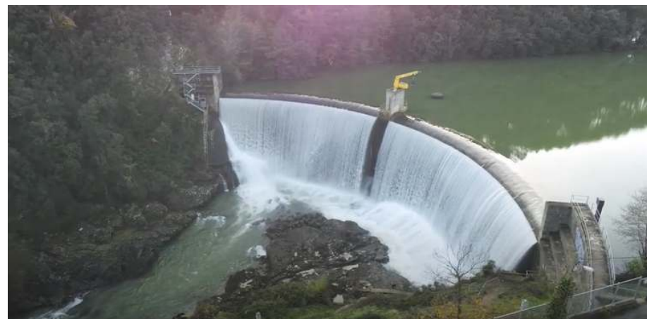
Photographie 4 : Le barrage des Cambous
