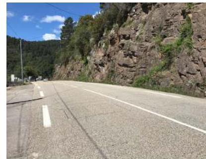
RN106 au droit du barrage vers Mende
