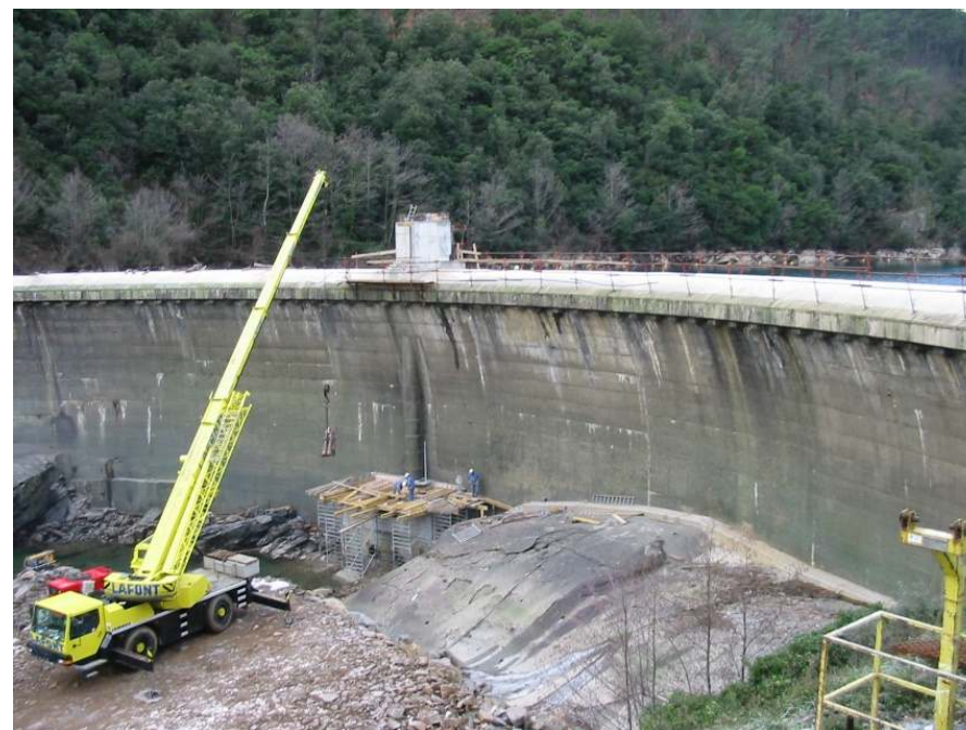
Photographie 10 : Plateforme de travail des travaux de 2002/2003
