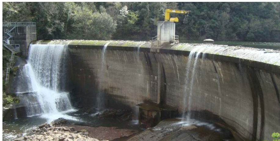
Photographie 3 : Le barrage des Cambous (avril 2019)
