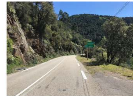
RN106 au droit du barrage vers Alès
