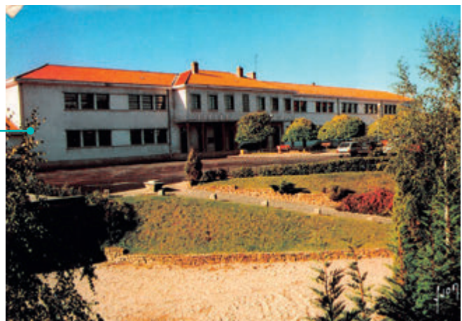
Travaux parking devant l'école durant le mandat Paul Chenguelia, maire de 1970 à 1989
