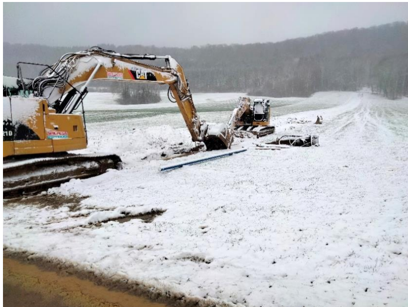
Travaux d'Interconnexion Ouvans Landresse
