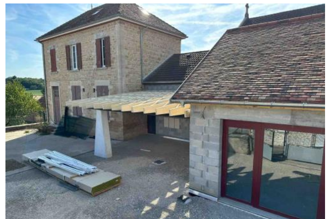
Préau en cours
