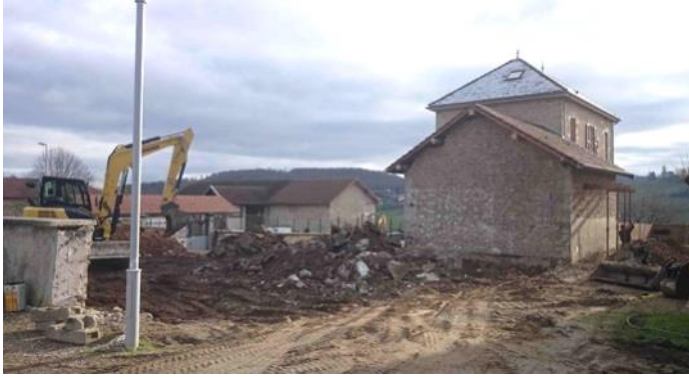
Démolition du préfabriqué
