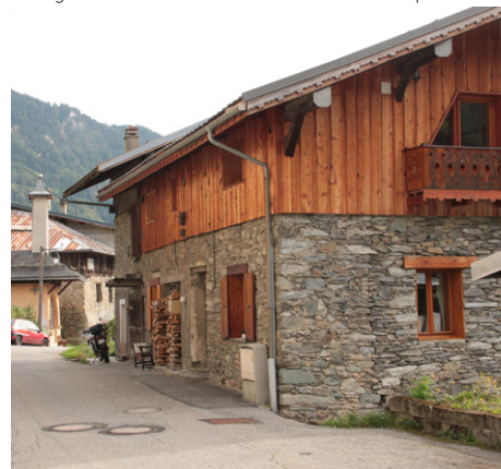
Le grès et schiste utilisé en sous bassement à Hautecour la Basse.
