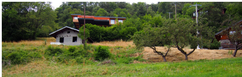
Maison sur pilotis au niveau de la Basse.
