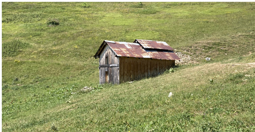
Cabane de berger dans l'alpage, bardage bois et toiture en tôle.
