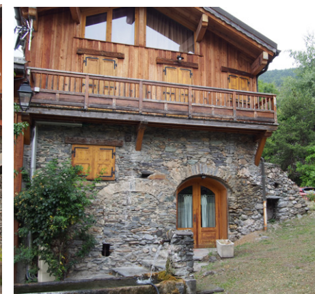
Calcaire et schiste utilisé en sous bassement.
