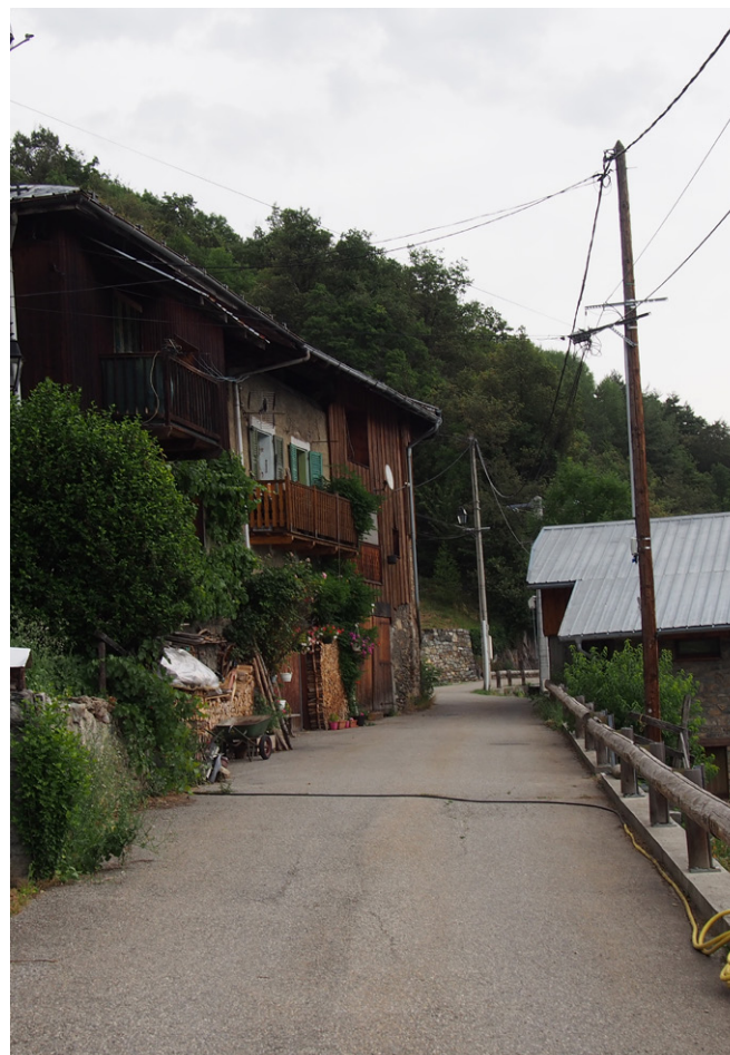
Chalets accolés à Hautecour la Basse.
