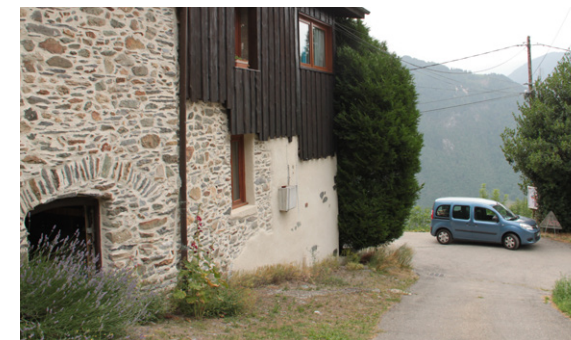
Grès et schiste en parement à Hautecour la Basse.
