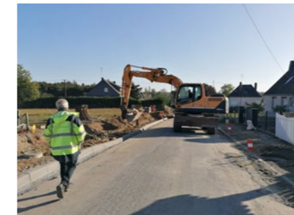
Travaux de réalisation des trottoirs Rue du Stade
