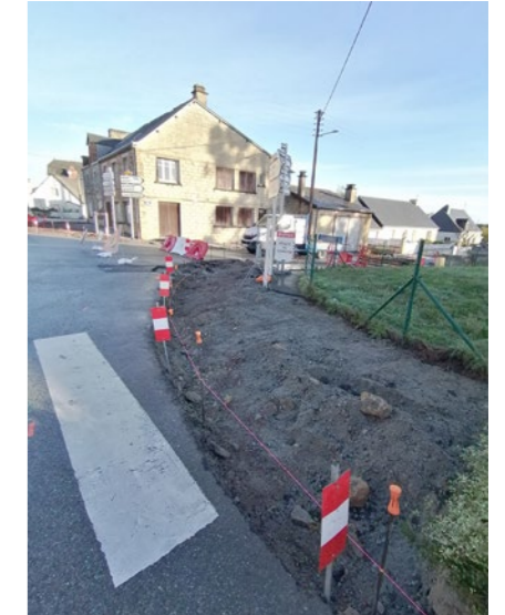
Travaux de réalisation des trottoirs Carrefour de la Pointe
