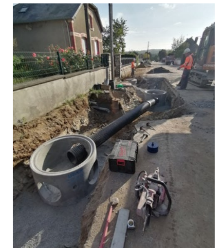
Travaux sur le réseau d'eau pluviale Rue du Stade
