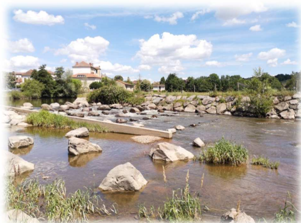
Partie amont de T2
