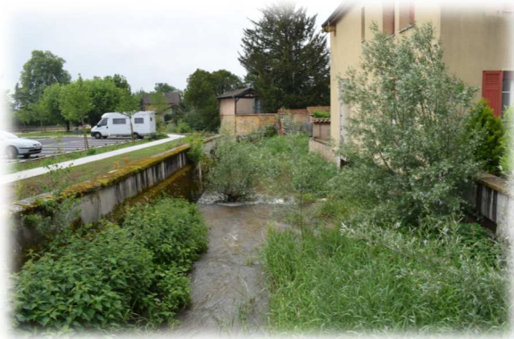
Partie amont de T3
