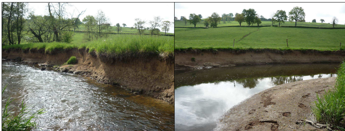
Figure 1-6 Vues de fronts riverains particulièrement exposés aux contraintes d'écoulement (berges concaves / travail sur toute la hauteur de la berge) - Clichés Biotec, mai 2009.
