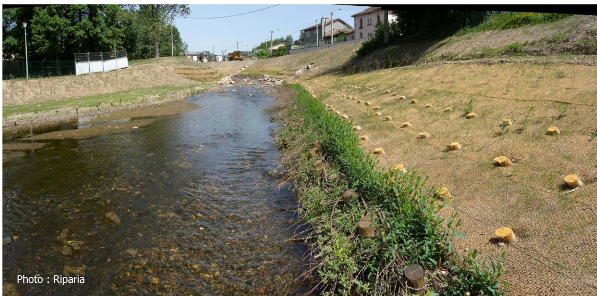
Photo 3 : Après travaux (juin 2009) : outre le recalibrage du cours d'eau et la suppression du seuil qui ne font pas parti des propositions du Sornin, l'ensemble des berges sont stabilisées à l'aide de techniques végétales.
