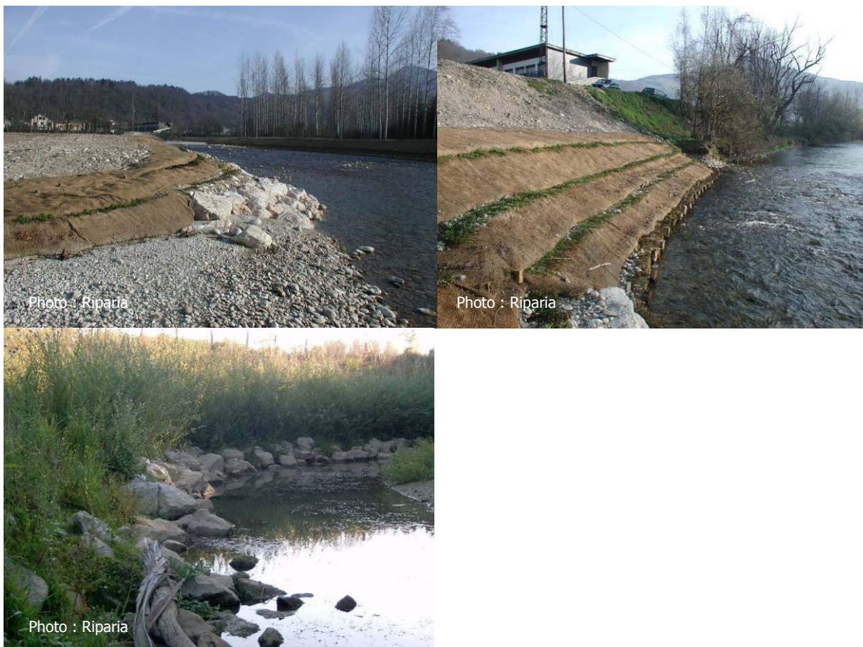
Photo 12 : Exemples de réalisation à l'aide de techniques mixtes (enrochement en pied + lits de plants et plançons) et de techniques végétales (fascines de saule et lits de plants et plançons). En haut : Le Guiers (38) ; en bas : La Lère à Réalville (82) après reprise de la végétation
