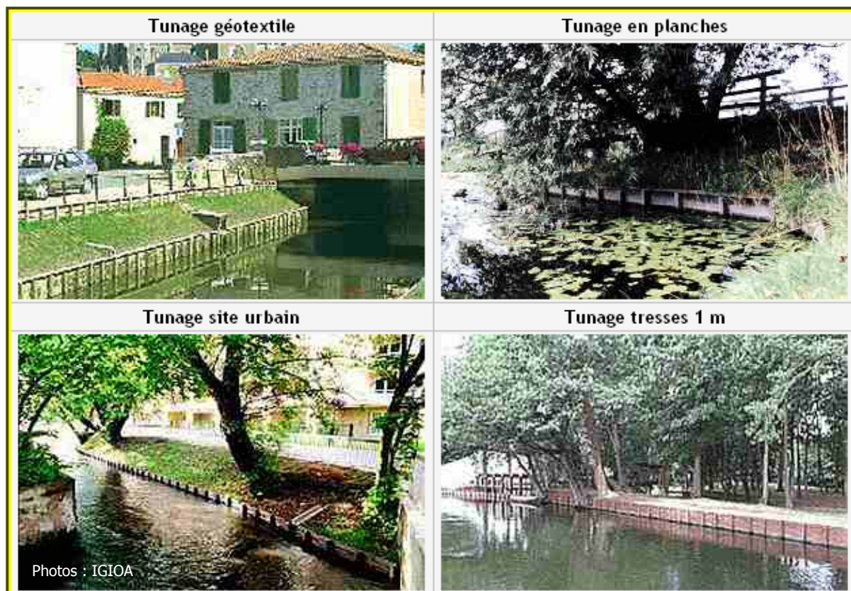
Photo 13 : Exemples de soutènement de berge à l'aide de tunage bois
