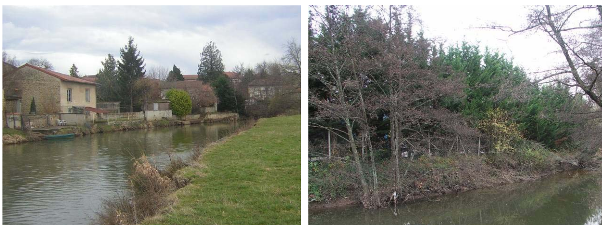
Photo 10 : 1 - berges maçonnées inesthétiques et hétérogène, vue depuis la rive gauche du seuil ; 2 – Clôture basculée, résineux en haut de berge
