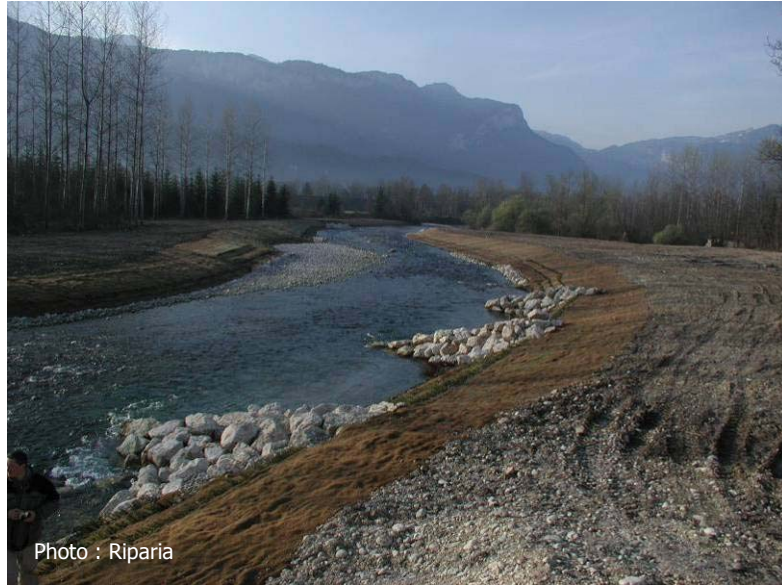
Photo 4 : Exemple d'épis défecteurs en enrochement (Le Guiers, 38)
