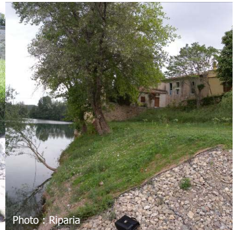
Photo 1 : Avant : Exemple d'intervention simple : retalutage et végétalisation (l'Hérault, 34) Ici, traitement d'une érosion, reprise d'un rejet pluvial (premier plan) et conservation d'un arbre remarquable ; Photo prise à réception des travaux, les plants sont donc trop petits pour être visibles sur la photo.
