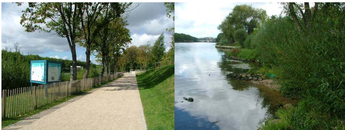
Photo 15 : aménagement des berges de Seine à Epinay-sur-Seine : 1 an après réception des travaux.
