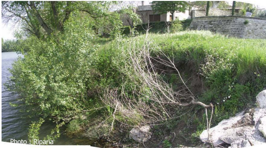
Photo 1 : Avant : Exemple d'intervention simple : retalutage et végétalisation (l'Hérault, 34) Ici, traitement d'une érosion, reprise d'un rejet pluvial (premier plan) et conservation d'un arbre remarquable ; Photo prise à réception des travaux, les plants sont donc trop petits pour être visibles sur la photo.
