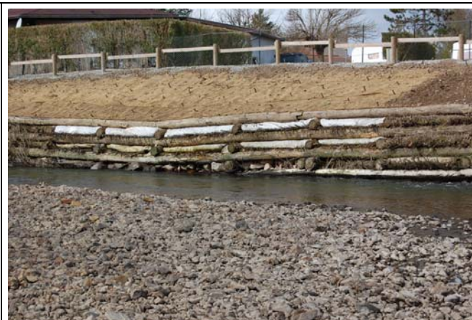
La présence du banc accroît la pression hydraulique en rive droite, sur le caisson.
