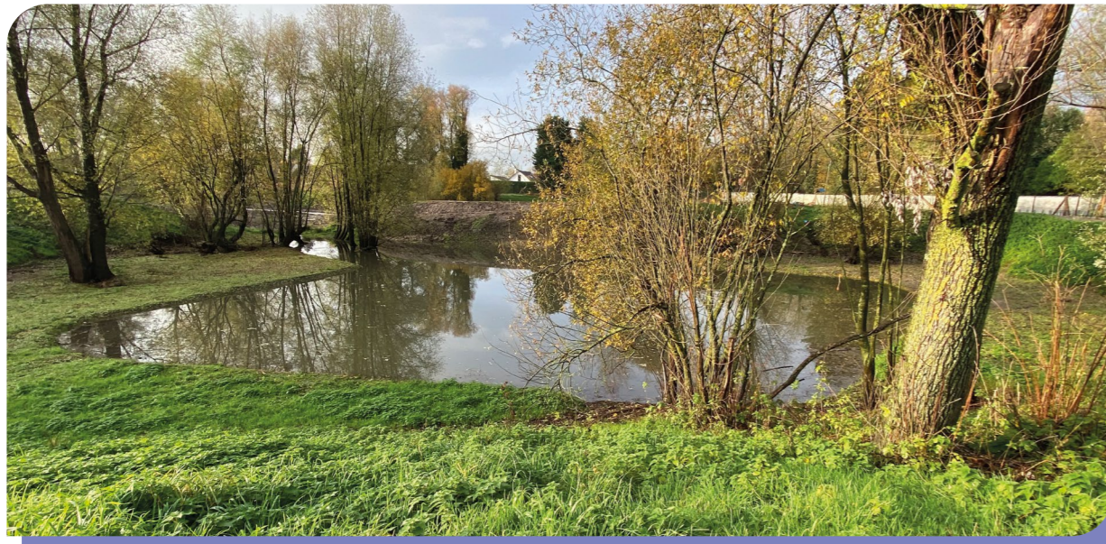
Bassin plat après terrassement sur les berges.
