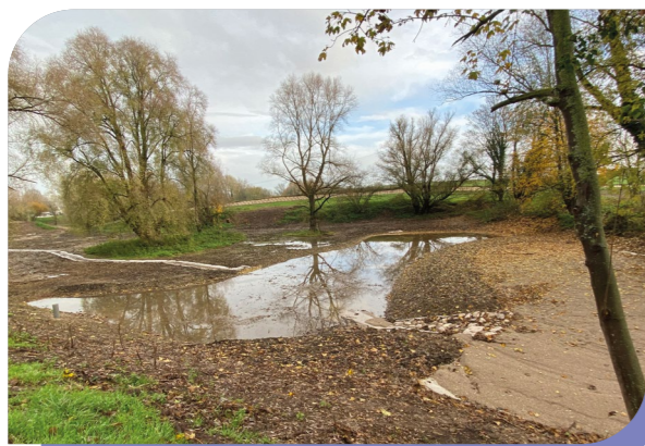
Lagunes de phytotraitement de l'eau pluviale.
