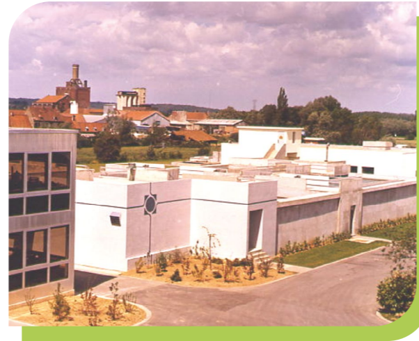
Unité de réalimentation de la nappe, MOULLE années 70
