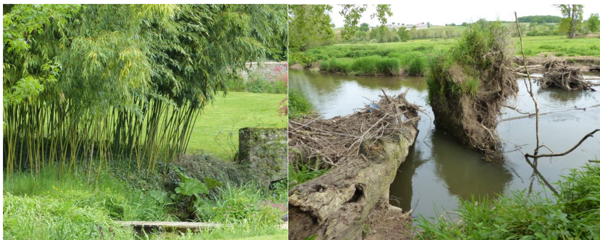
Figure 29 : Bambous plantés sur un ruisseau (à gauche) ; Peuplier sur berge effondré (à droite)
