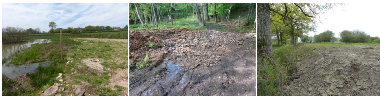
Figure 84 : Remblais en zones humides
