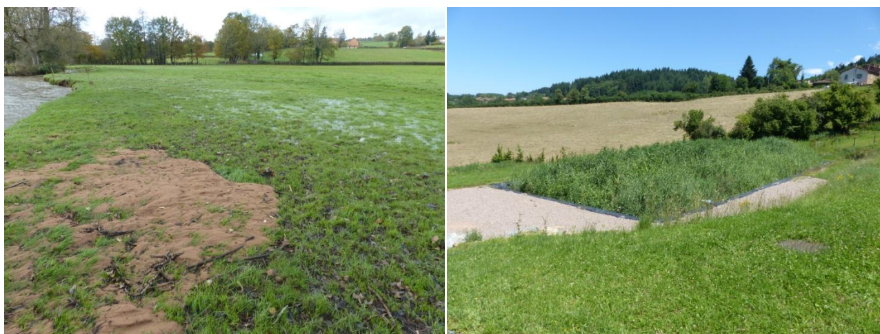
Figure 11 : Dépôts de sédiments suite à une crue ; zone humide artificielle (filtre planté de roseaux) - communes de St Igny de Roche et Ecoche (source : SYMISOA 2014)
