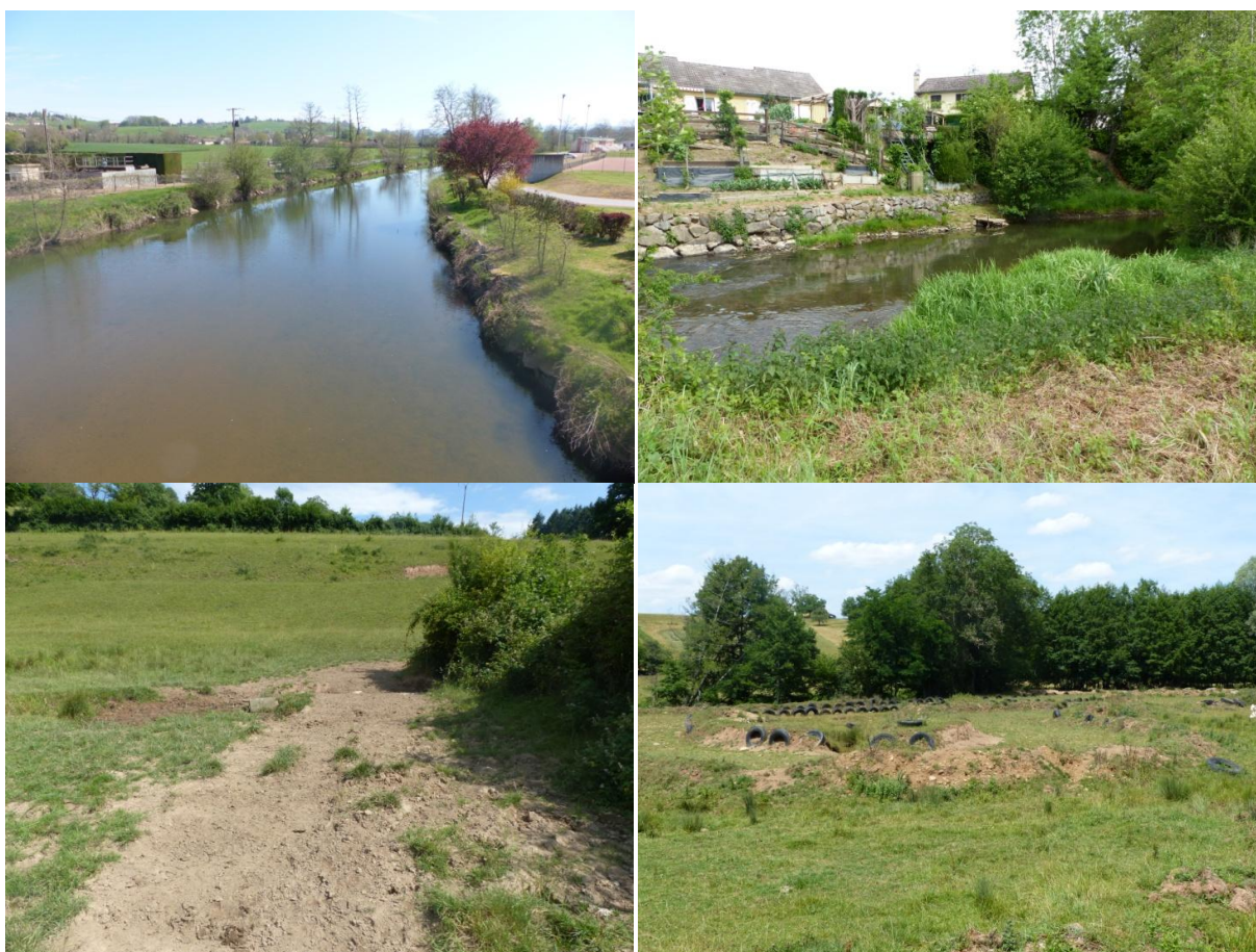
Figure 63 : Artificialisation du Sornin (endiguement en haut à gauche, enrochement en haut à droite) ; busage en prairie humide (en bas à gauche) ; Aménagement d'un terrain de cross en prairie humide avec fossés (en bas à droite)
