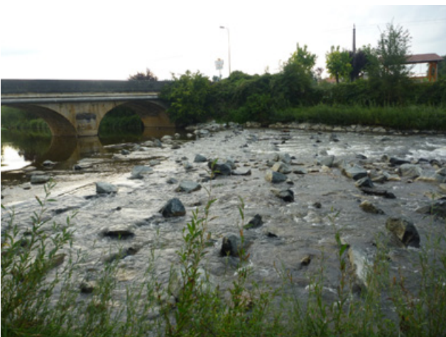
Figure 15 : Passe à poissons sur seuil SB127 à Pouilly-sous-Charlieu
