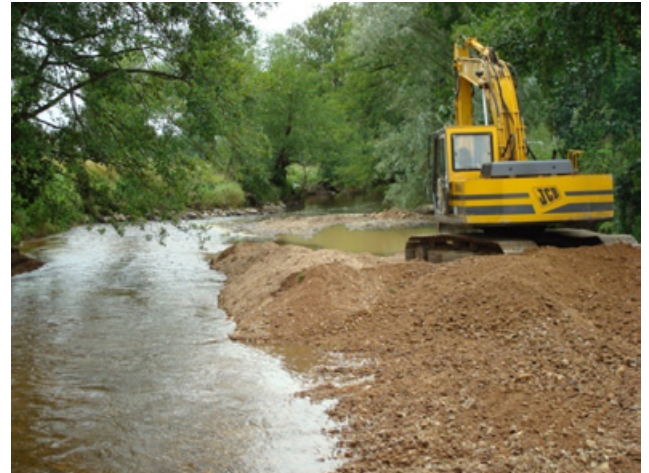
Figure 21 : Restauration de la section d'écoulement à Chateauneuf
