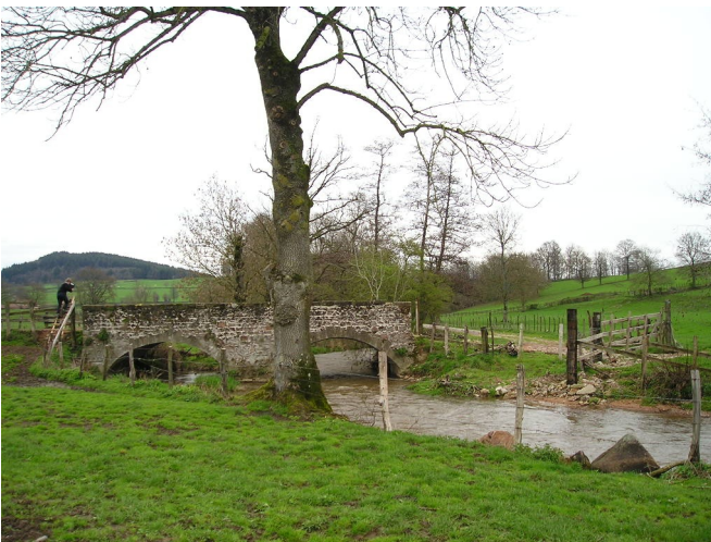
Figure 10 : Pont à Varennes
