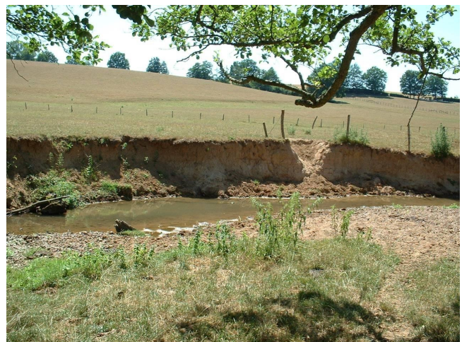
Figure 37 : Érosion au droit d'une prairie sur le Sornin aval
