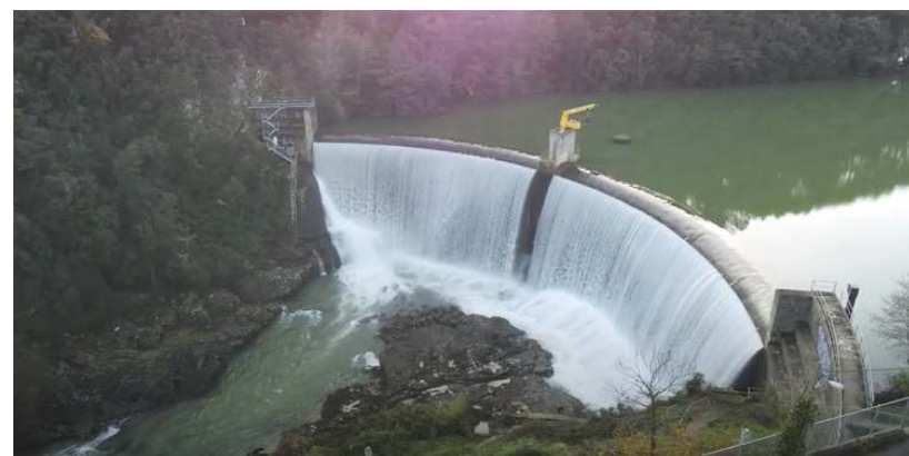
Photographie 3 : Le barrage des Cambous
