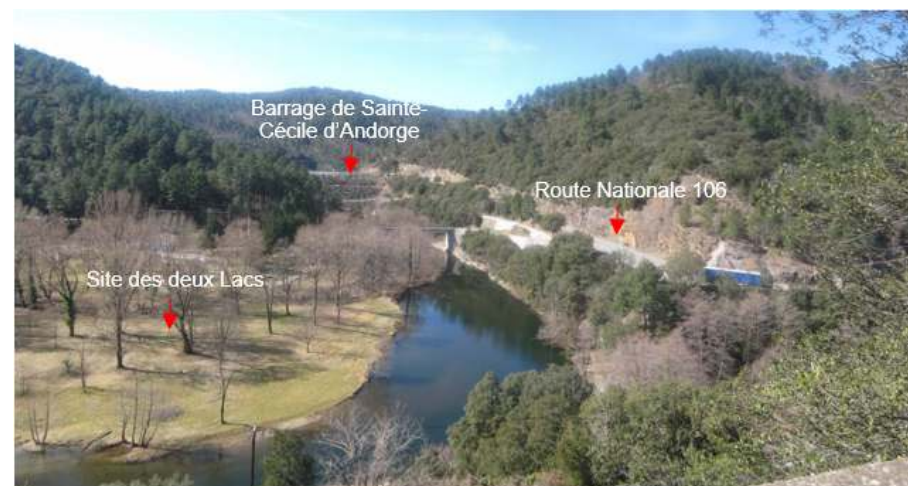
Figure 6 : Le Site des Deux Lacs, site retenu pour les installations de chantier du projet de sécurisation du barrage de Sainte-Cécile d'Andorge
