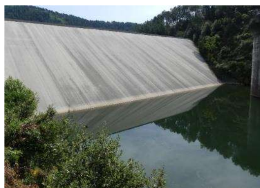
Barrage nord côté amont
