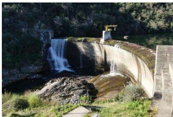
Barrage sud côté aval
