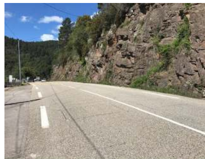
RN106 au droit du barrage vers Mendé
