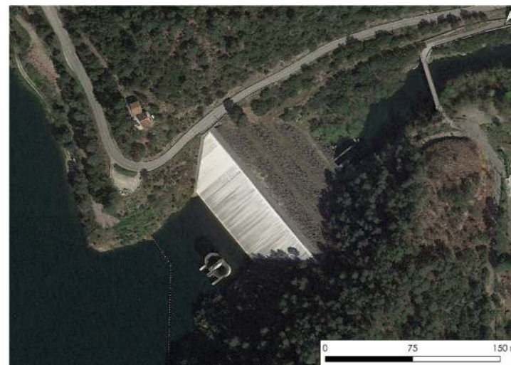
Carte 55 : Emprise au sol du barrage actuel
