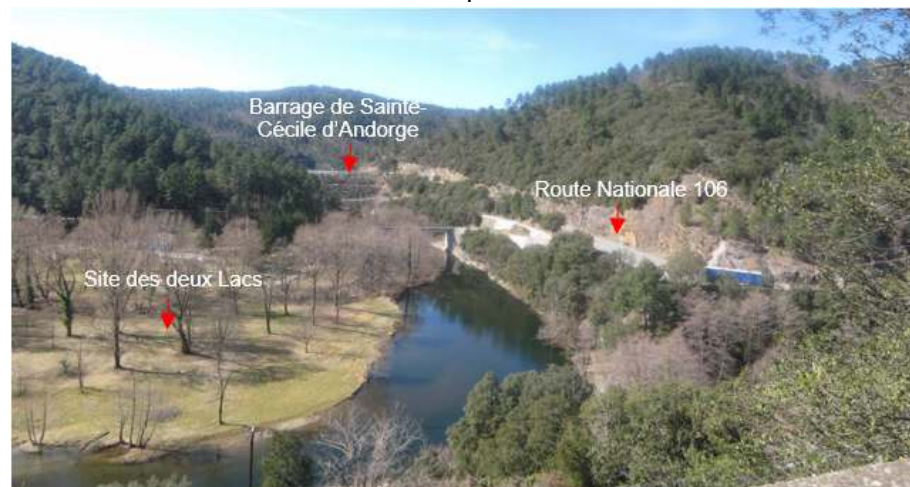
Figure 1 : Le Site des Deux Lacs, principale zone d'accueil des installations de chantier
