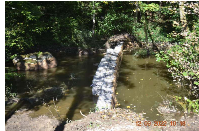
Photographie 4 : Dispositif de barrage filtrant mis en œuvre dans le cadre de la vidange du barrage des Settons (maîtrise d'œuvre ISL-EGIS)
