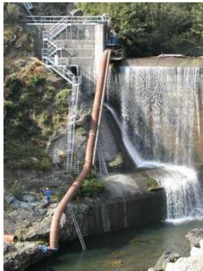
Photographie 5 : Siphon lors des travaux sur le barrage des Cambous (2002/2003)
