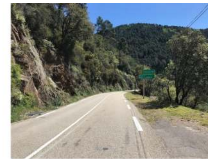
RN106 au droit du barrage vers Alès
