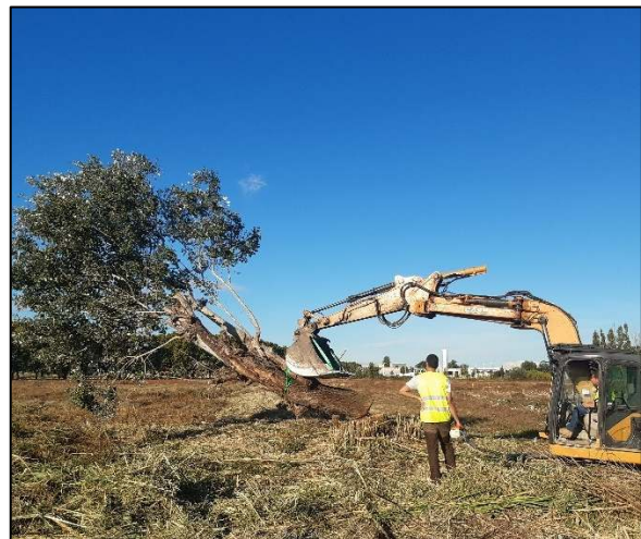
Abattage à l'aide d'une pelle mécanique et d'une tronçonneuse
