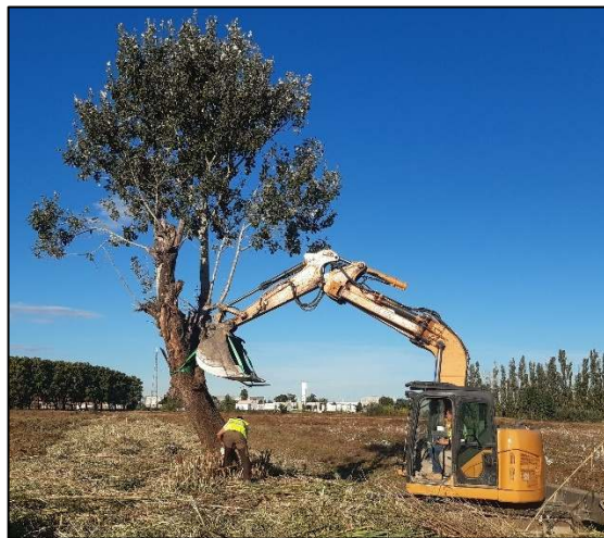
Abattage à l'aide d'une pelle mécanique et d'une tronçonneuse
