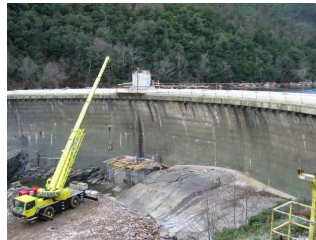
Photographie 11 : Plateforme de travail des travaux de 2002/2003
