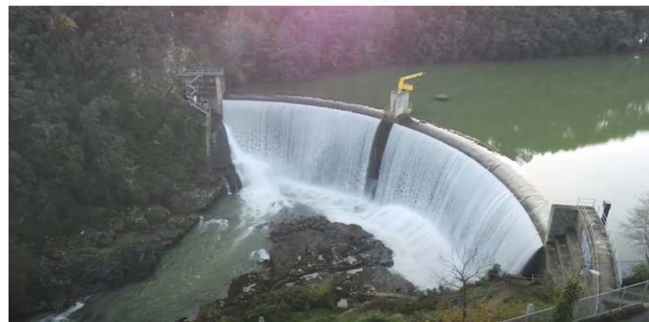
Photographie 17 : Surverse du barrage des Cambous en période de crue du Gardon d'Alès
