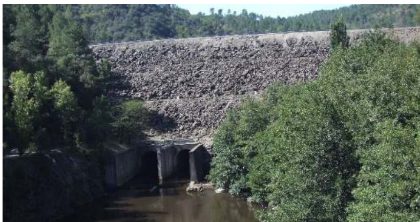
Photographie 22 : Parement aval du barrage de Sainte-Cécile d'Andorge
