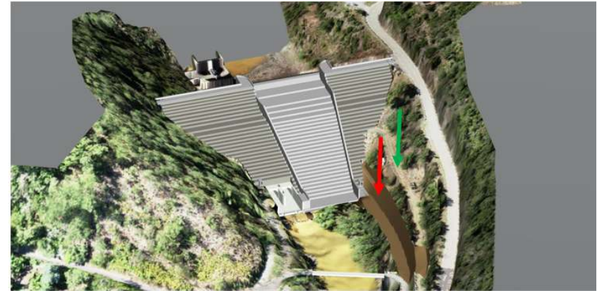
Figure 8 : Création d'un accès au barrage en rive gauche (flèche rouge) et confortement de la piste existante (ancienne RN 106) (flèche verte)
