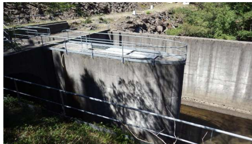
Photographie 7 : Chambre de restitution aval, vue depuis l'aval du barrage
