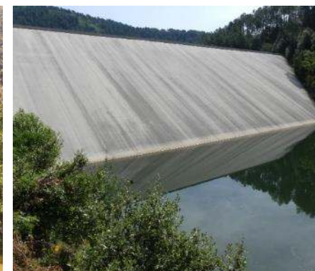
Barrage nord côté amont
