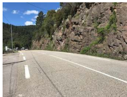
RN106 au droit du barrage vers Mende
