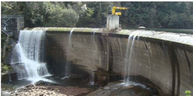
Photographie 18 : Le barrage des Cambous (avril 2019)
