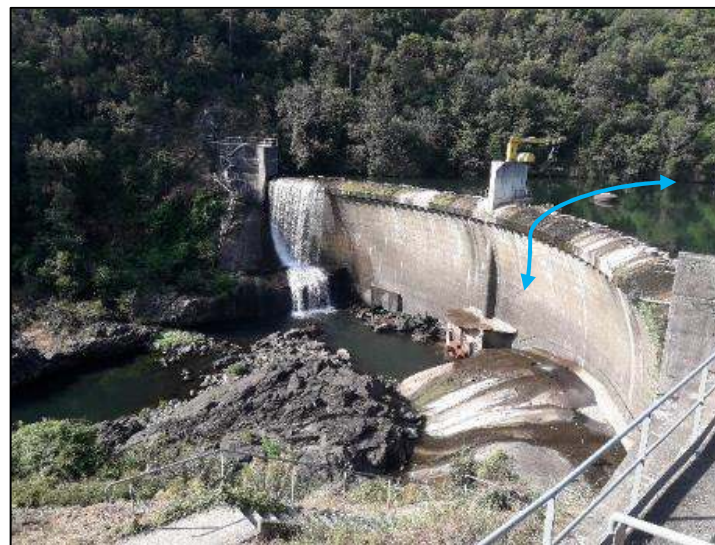
Barrage de Cambous, perméable aux déplacements des mammifères semi-aquatiques
