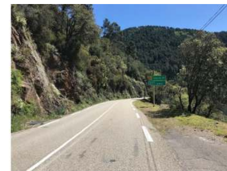
RN106 au droit du barrage vers Alès
