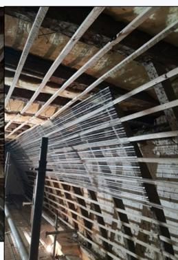
Pose de l'armature métallique avant plâtrage plafond de la nef
