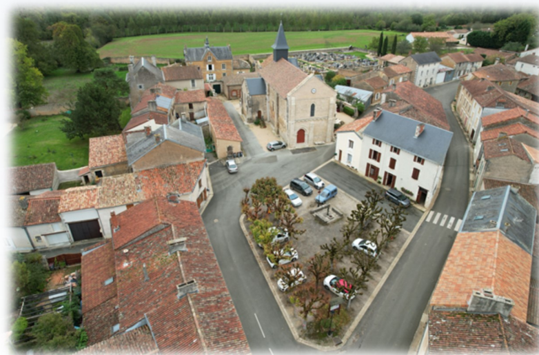
Vue aérienne après les travaux
