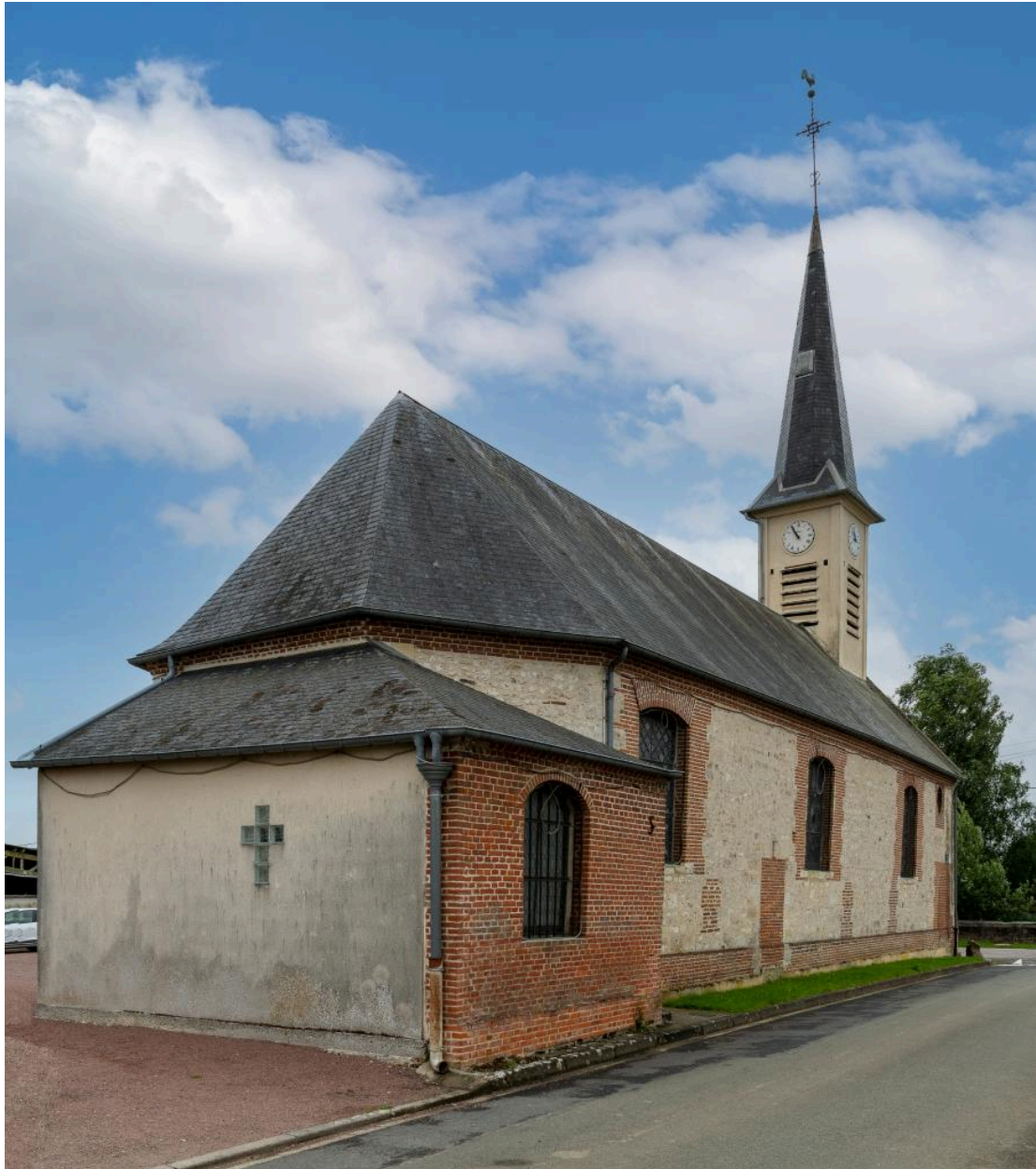
Vue du chevet et de la sacristie depuis l'est.
