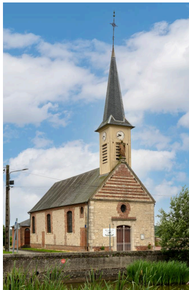
Vue générale depuis le nord-ouest. Phot. Marc Kérignard IVR32_20216000839NUCA
