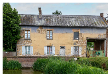
Logis en pans de bois torchis avec entrée charretière, n°50 rue Principale, vue depuis l'est. Phot. Marc Kérignard IVR32_20216000852NUCA
