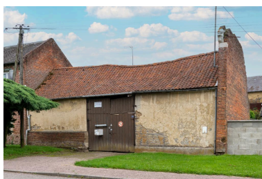
Grange sur rue d'une ancienne ferme, n°40 rue Principale, vue depuis l'est. Phot. Marc Kérignard IVR32_20216000863NUCA
