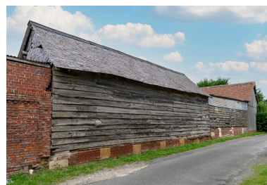
Bâtiment agricole essenté en blins de bois, n°45 rue Principale, vue depuis le sud-ouest. Phot. Marc Kérignard IVR32_20216000859NUCA
