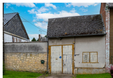
Entrée charretière avec fenêtres à engranger ou fenêtres d'atelier, n°27 rue Principale, vue depuis l'ouest. Le mur à gauche pourrait matérialiser l'ancien emplacement d'une autre grange. Phot. Marc Kérignard IVR32_20216000868NUCA
