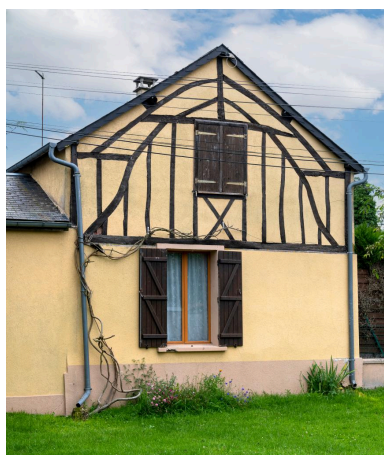
Pignon avec pans de bois apparents au n°52 rue Principale, vue depuis l'est. Phot. Marc Kérignard IVR32_20216000844NUCA
