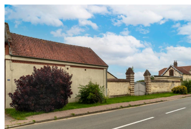
Entrée et anciens bâtiments de l'usine Lecomte, vue depuis le sud-est. Phot. Marc Kérignard IVR32_20216000876NUCA
