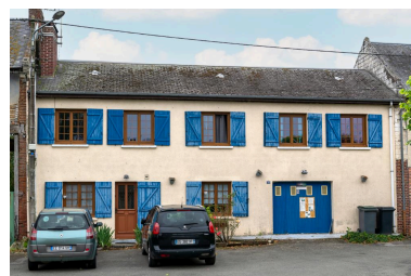
Ancien café Patte-Liger, n°48 rue Principale, vue depuis l'est. Phot. Marc Kérignard IVR32_20216000853NUCA
