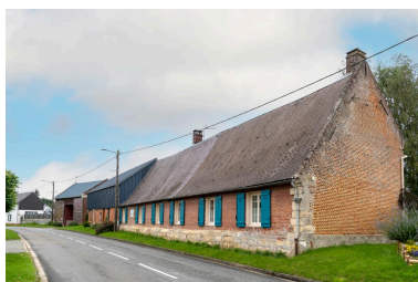
Logis ayant pu appartenir à l'ancien château (ferme?), 18e siècle, n°1 rue de l'Église, vue depuis le sud-est. Phot. Marc Kérignard IVR32_20216000851NUCA
