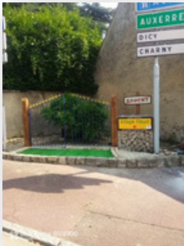
Création carrefour RD 34 (rue de l'Église, Douchy) et RD 943
