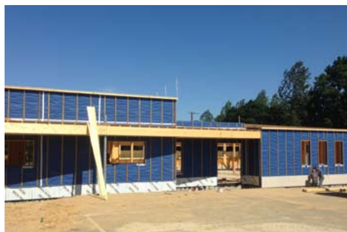
Les travaux de gros oeuvre sont presque terminés
