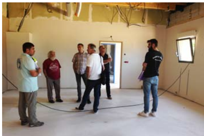
Réunion de chantier, avant la pose des sols
