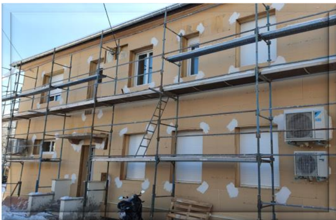
Pose du bardage intermédiaire
