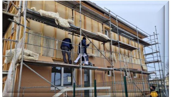
Pose de la laine
