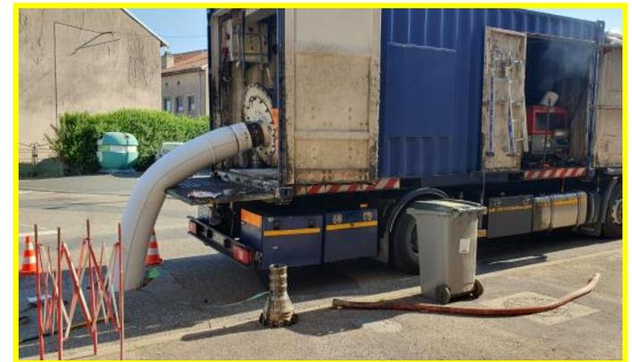
Ce sont des travaux réalisés en juin avec le chemisage des canalisations d'assainissement.
