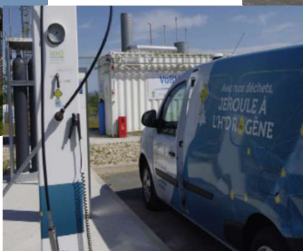
Une station hydrogène
