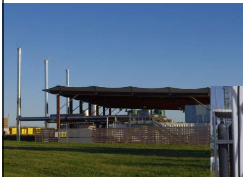
La cogénération (éq. 10 000 foyers)
