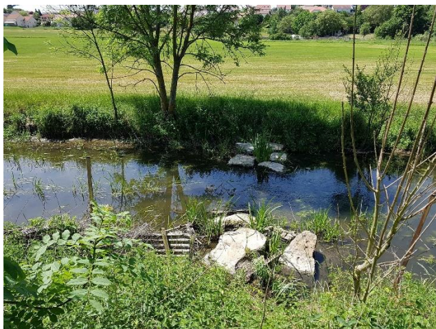
Figure : Seuil de la rivière
