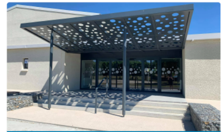
Rénovation salle Félix Roquefort et salle de l'Orbiel
