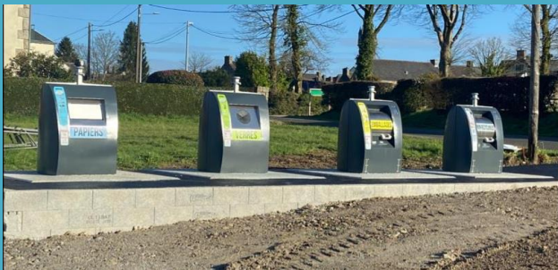
Colonnes enterrées à l'atelier municipal
