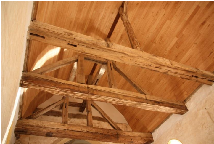
Parquetage de la voûte.
