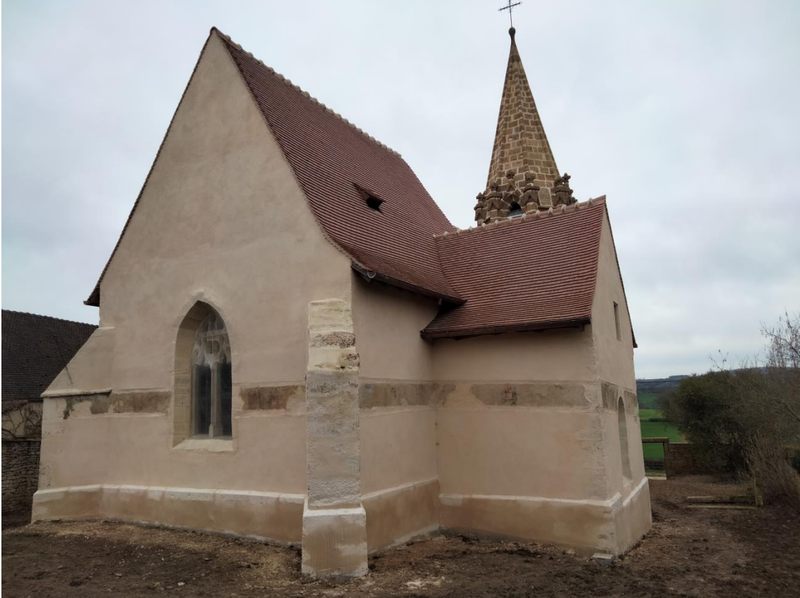
Eglise restaurée vue du chevet.
