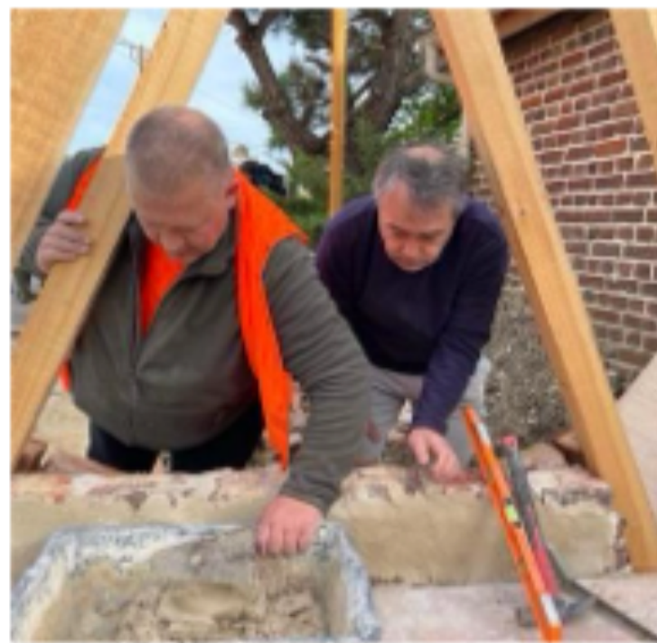
On explique comment prendre la bonne quantité de béton de chaux.
