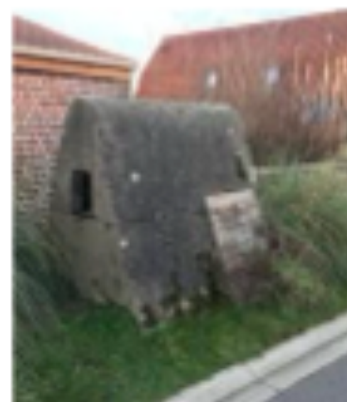
Le puits de la Trousse-Bière avant le début des travaux.
