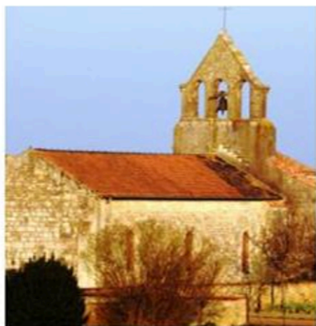
La rénovation de la charpente de l'église, parmi les travaux budgétés en 2024. (Photo NR)
