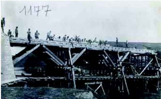
Construction d'un pont de chemin de fer sur la Sereth
