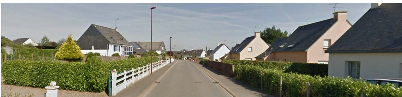
Route de Néant-sur-Yvel au nord : route bordée de trottoirs
