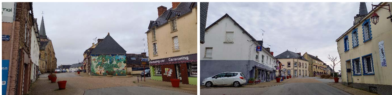
Rue Nationale, trottoirs et sécurisation des traversées piétonnes
