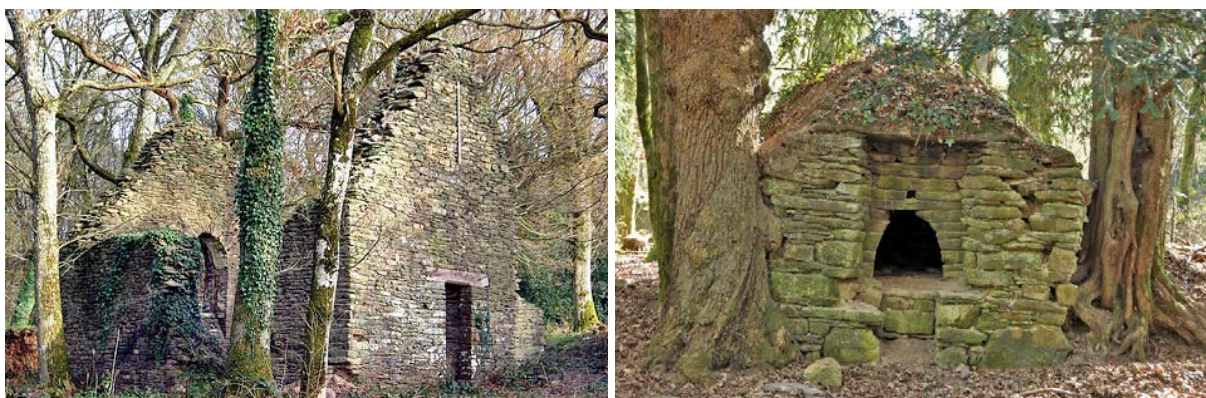
Ruines de la chapelle Sainte Anne, chapelle du village des Forges et four à pain du site de Guillerien
