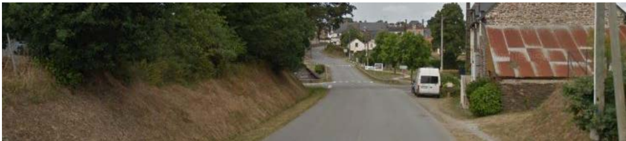
Route d'Augan au sud : double sens et chemin piéton sur la droite
