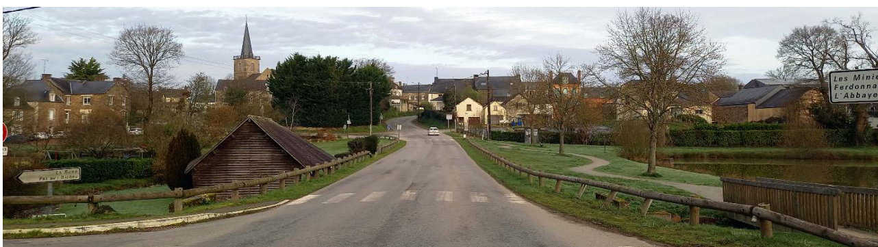
Éléments paysagers forts marquant le seuil d'entrée dans le bourg de CAMPÉNEAC
