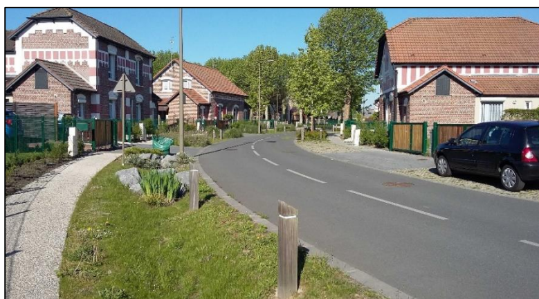
Figure 43 : Exemples d'aménagement avec des noues en bordure de voiries/parkings (Région de Douai)
