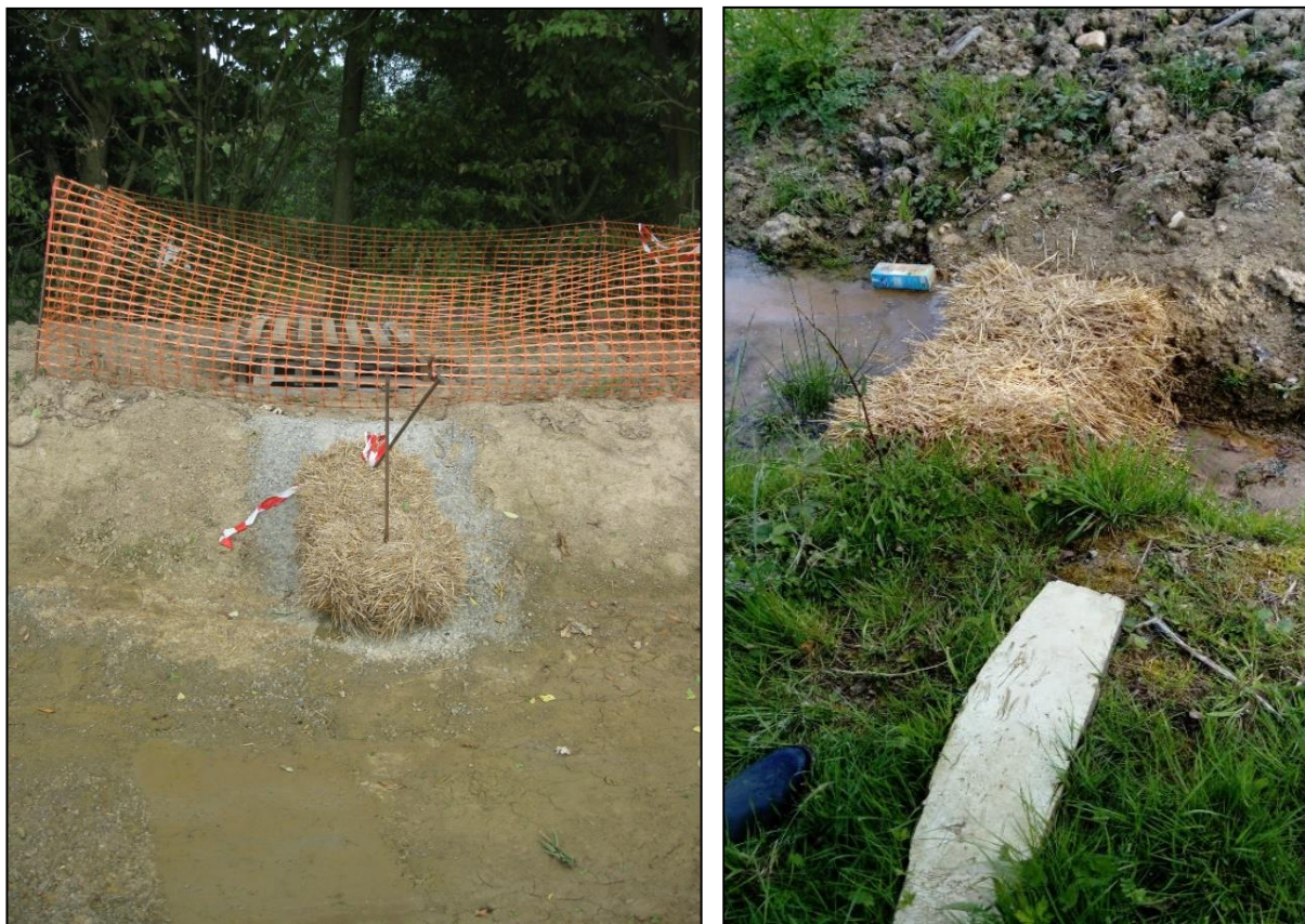
Photo : Emplacements du filtre à particules fines (botte de paille) pendant la phase des travaux au niveau du bassin d'orage
