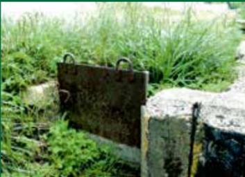
Portes simples à anneau pour orienter l'eau dans les fossés. Simple ring gates to direct water into ditches.
