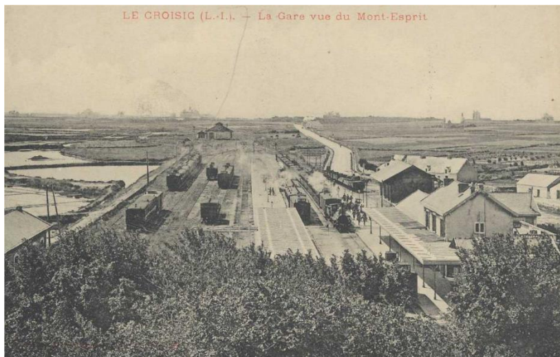
La gare vue du Mont-Esprit
