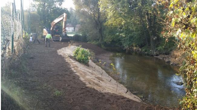
Les travaux de stabilisation des berges en techniques mixtes ont été réalisés courant octobre par l'équipe du SYMISOA, avec l'appui d'un pelleteur.
