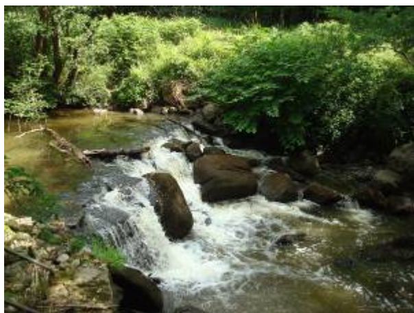
Seuil ‘Les Charmières’ (ROE 31781) – Etat initial
