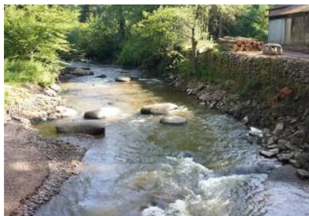
Site après travaux
