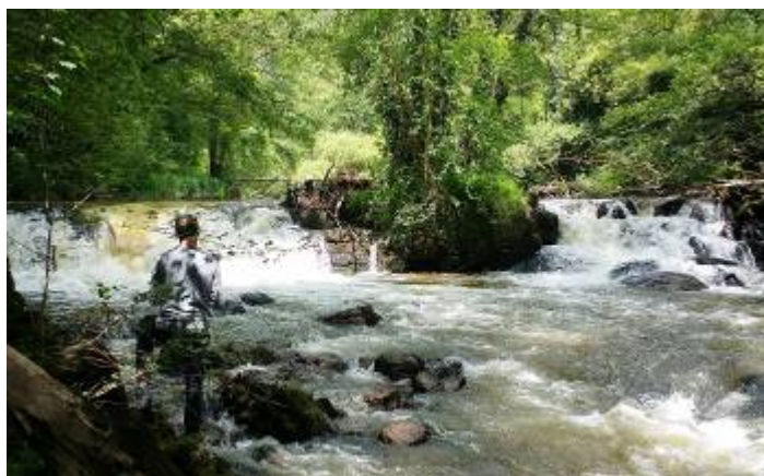
Seuil ‘Ancienne usine’ (ROE 31783) – Etat initial
