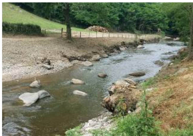
Site après travaux
