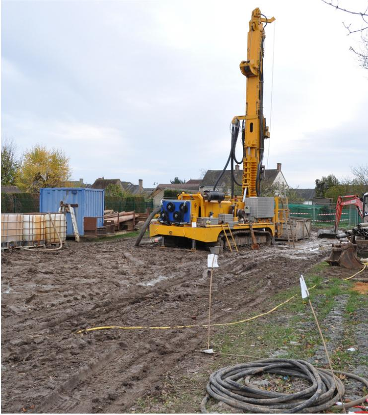
Forage de 11 puits géothermiques à 100m de profondeur
